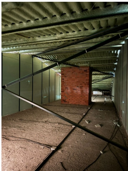
Espai sota coberta transitable
