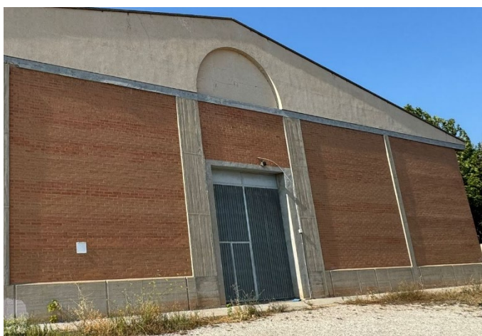
Accés façana sud
