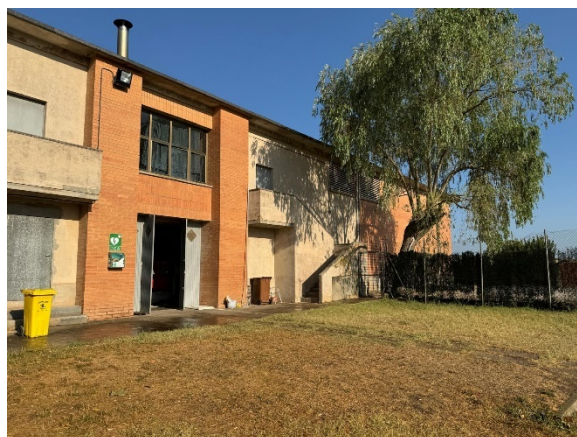
Accessos façana est
