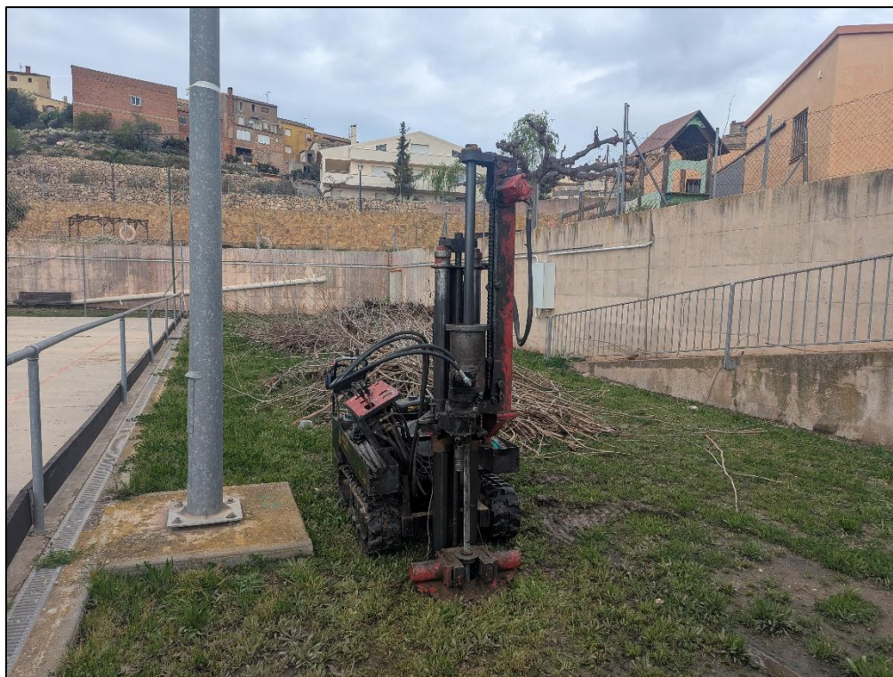
Vista penetròmetre nº 3
