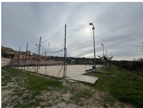
Vista esquina Noroeste
