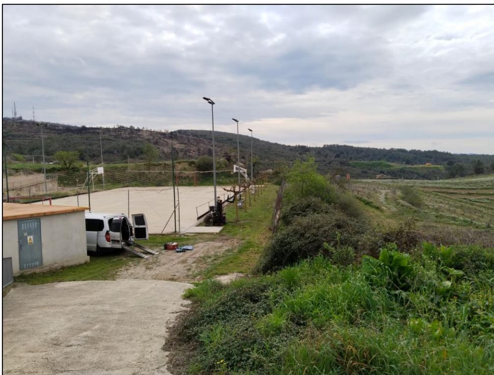
Vista zona d'actuació
