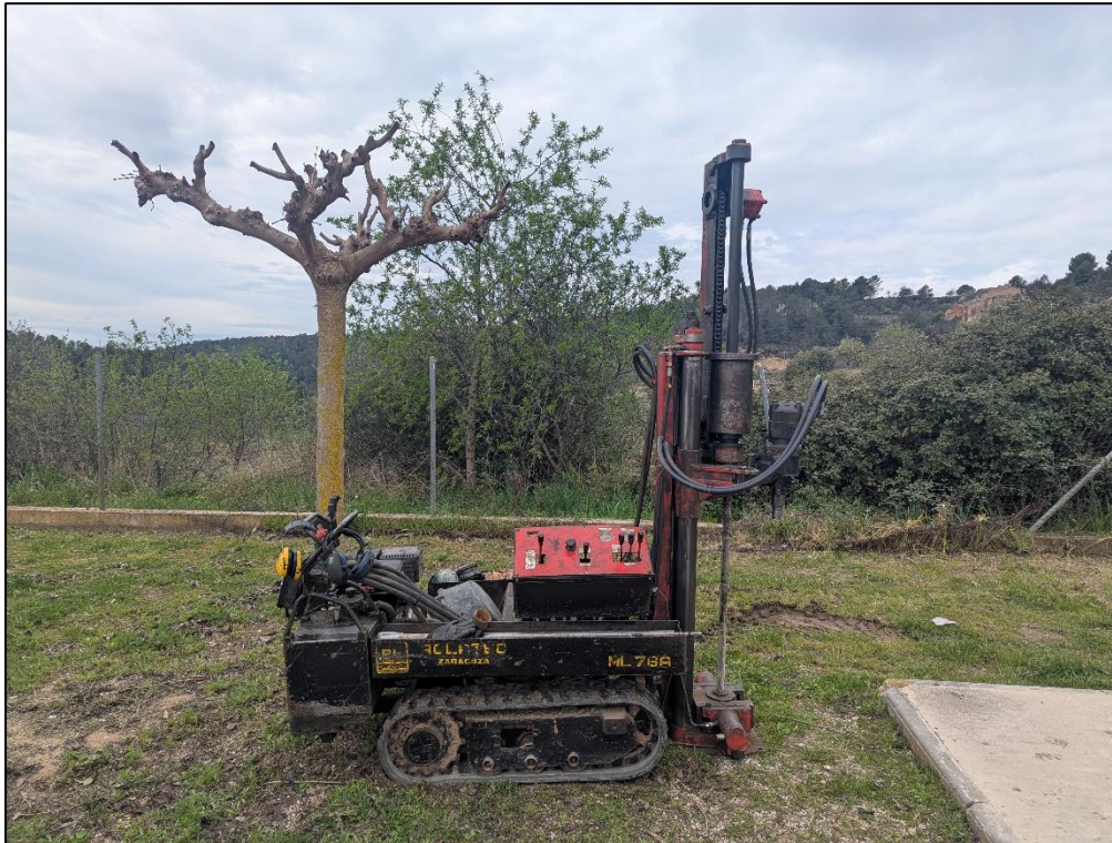
Vista penetròmetre nº 1
