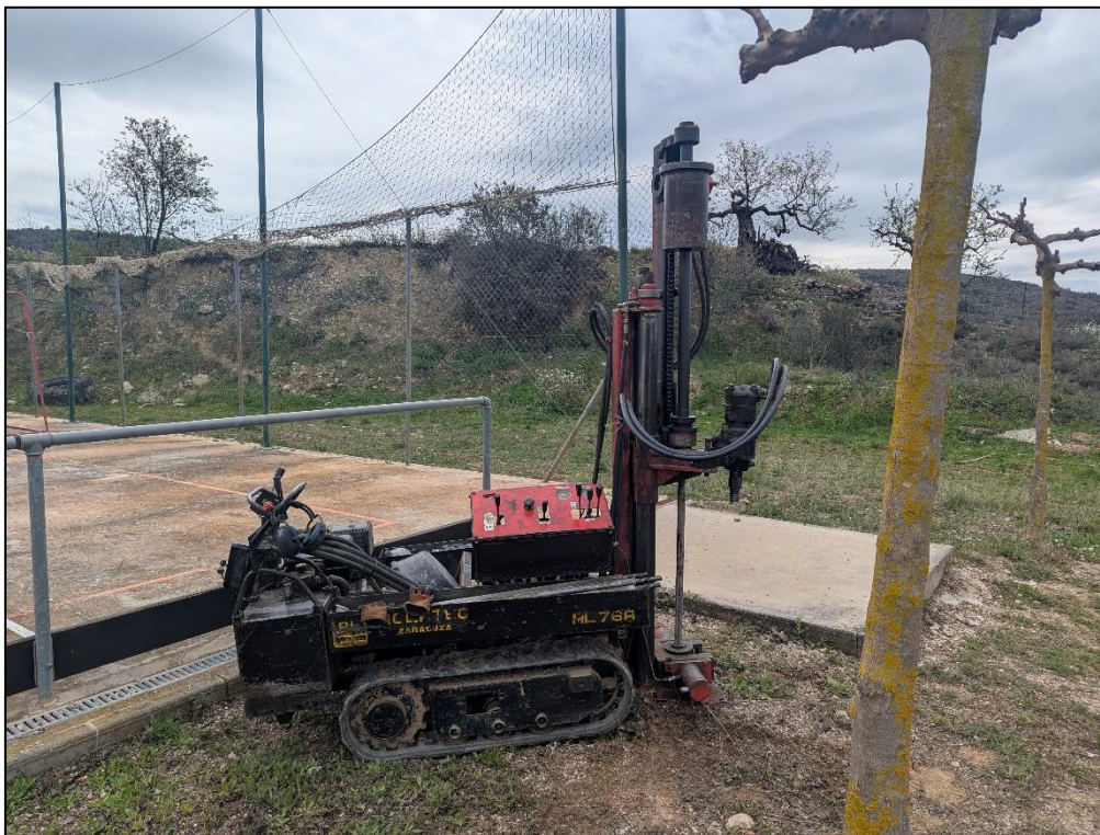
Vista penetròmetre nº 2
