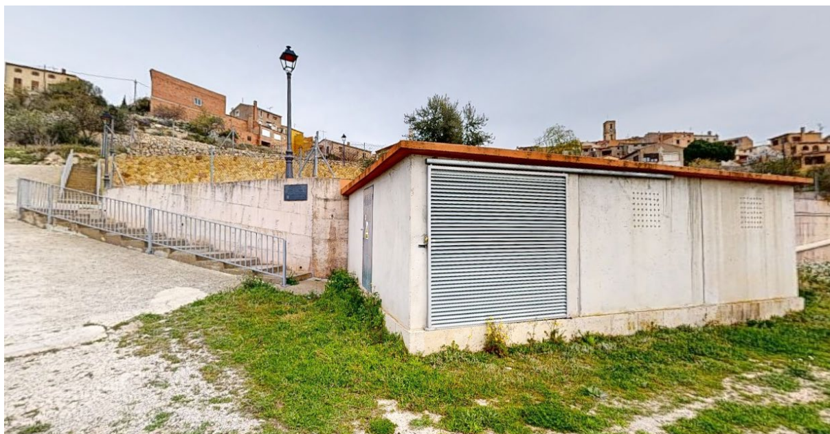
Acceso escalonado desde área de piscina hacia pista deportiva
