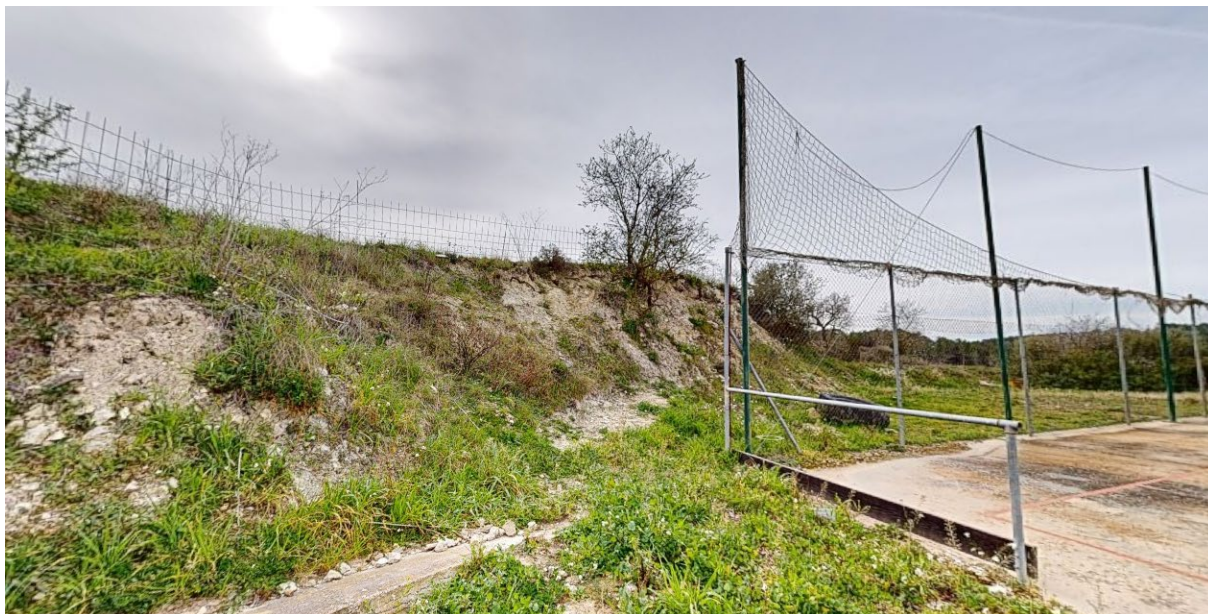
Vista de talud próximo situado en esquina sureste
