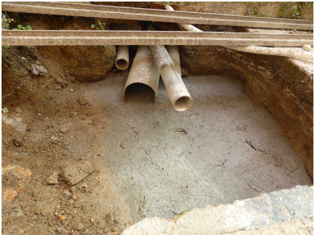
FIG. 10 i 11 - INSTAL·LACIONS INTERIORS PENDENTS DE CONNECTAR AMB L'EXTERIOR
