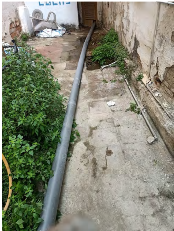
FIG. 8 i 9 - REPARACIÓ PROVISIONAL SANEJAMENT EXTERIOR
