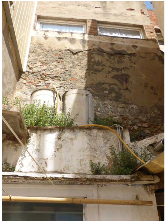
FIG.12 i 13 - CONNEXIÓ PROVISIONAL SANEJAMENT i DIPÒSITS D'AIGUA DE FIBROCIMENT P. BAIXA
