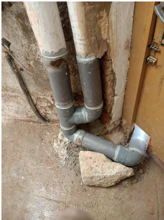
FIG. 8 i 9 - REPARACIÓ PROVISIONAL SANEJAMENT EXTERIOR
