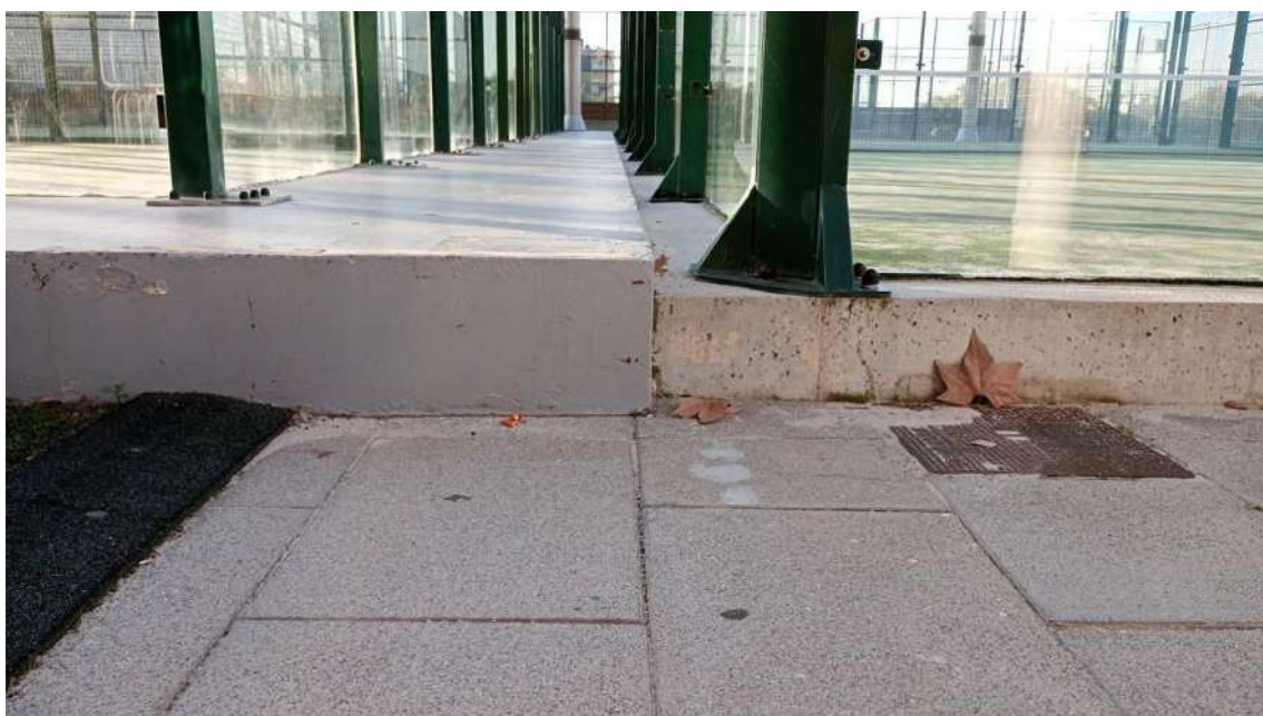
Ancoratges estructura tancament pista de pàdel
