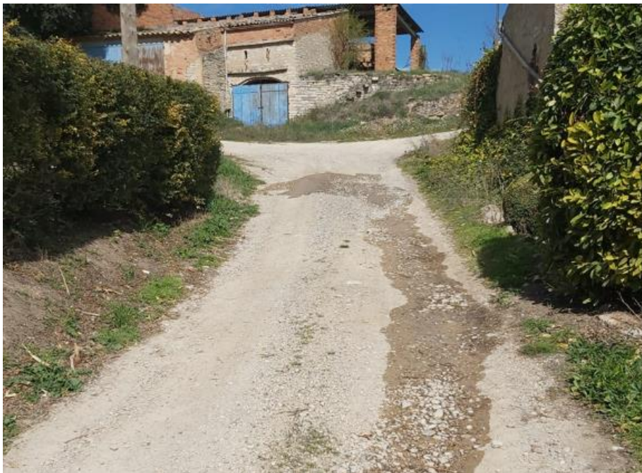
Figura 8: Traçat de la xarxa d'abastament en baixa a Cal Vila (Ferran) on s'evidencien les ruptures.
