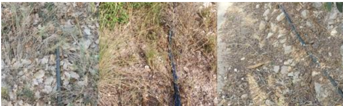
Figura 2: Canonada de mitja polzada per sobre el camí que omple el dipòsit de l'ADF a Ferran
