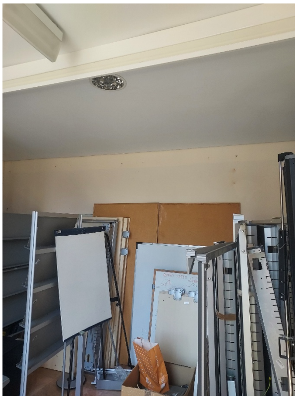
Fotografia 1. Espai actual de la futura Infermeria.
