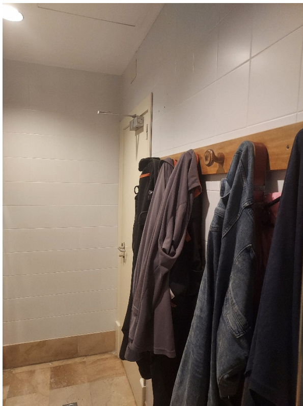
Fotografia 9. Diferents imatges dels Serveis Sanitaris actuals.
