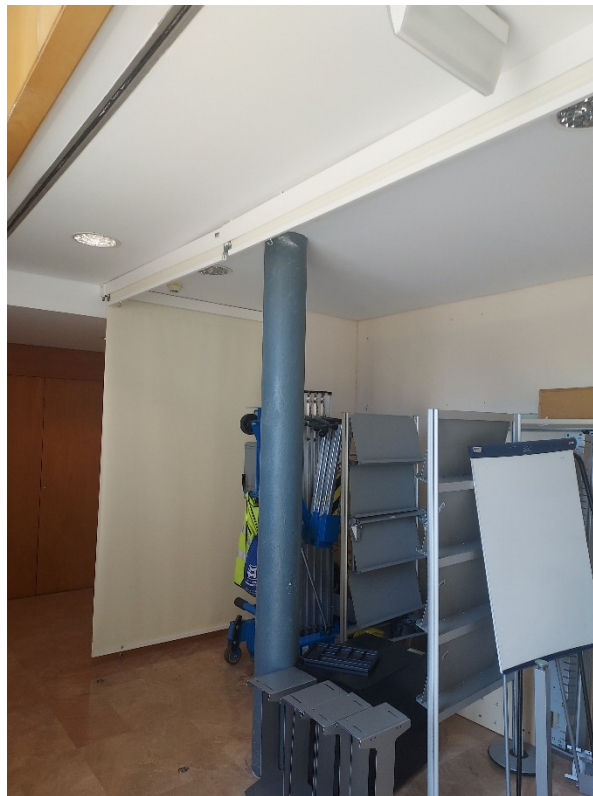
Fotografia 1. Espai actual de la futura Infermeria.
