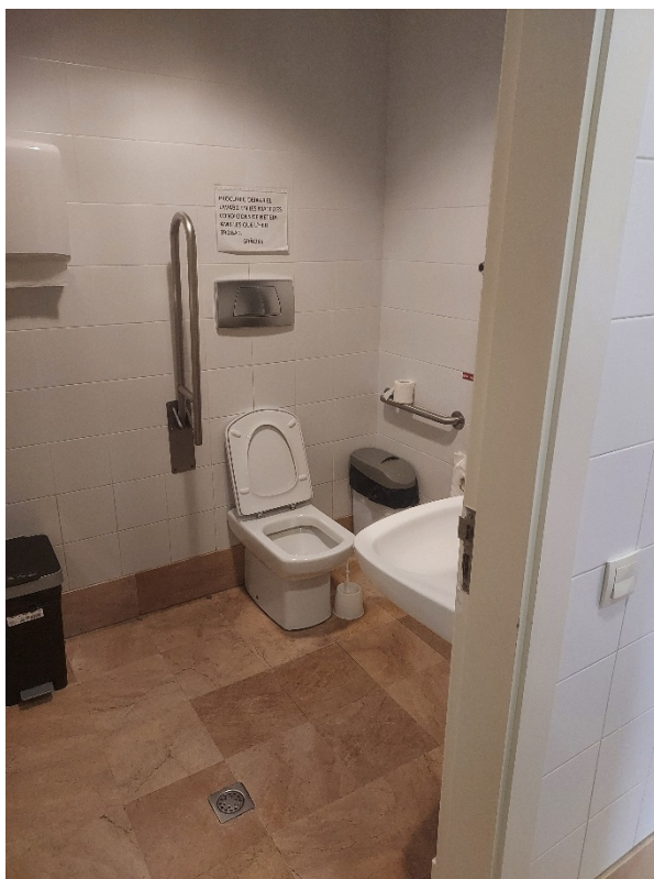
Fotografia 4. Diferents imatges dels Serveis Sanitaris actuals.
