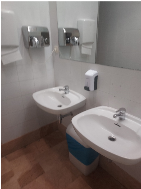
Fotografia 3. Diferents imatges dels Serveis Sanitaris actuals.
