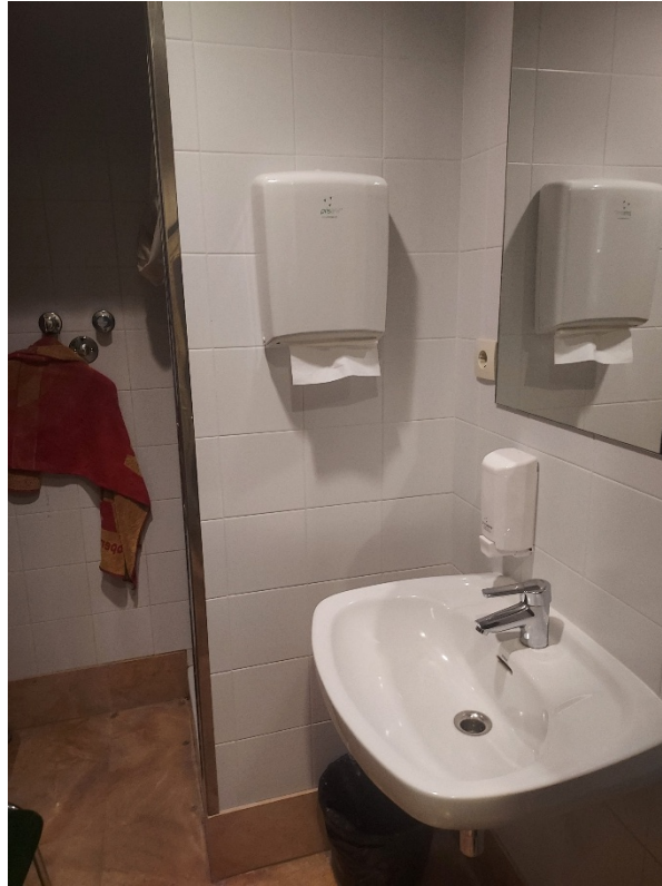
Fotografia 2. Imatge d'una part de la zona de lavabos actuals.
