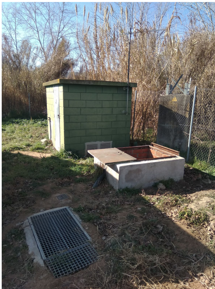
Foto 1: Visió del recinte tancat del pou, l'arqueta i la caseta al costat.
