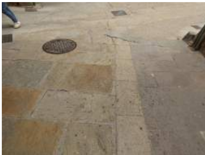
FIG.4. Detall del paviment del carrer d'Escasany.
