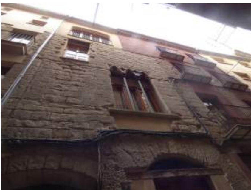
FIG 6.- Vista de la façana de la Casa Martines amb orígens gòtics.
