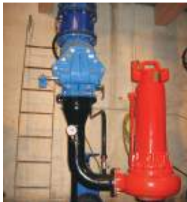
VÁLVULA DE RETENCIÓN A CLAPETA CON CONTRAPESO
