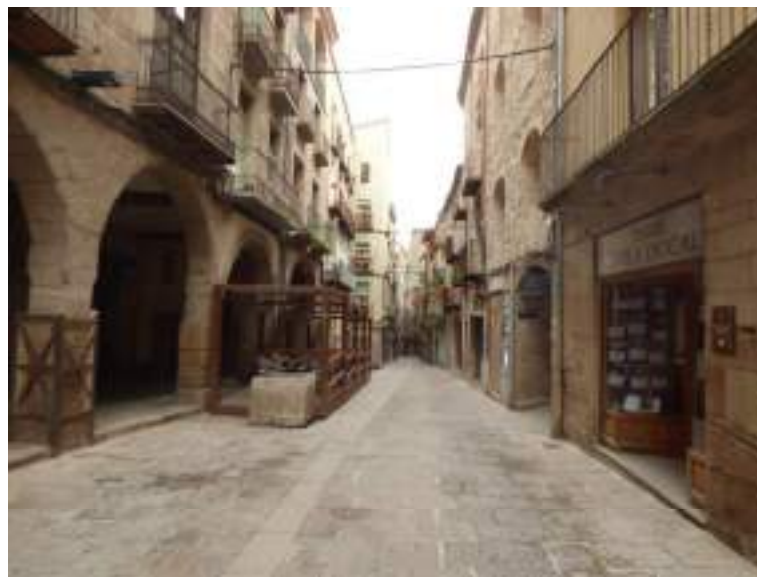
FIG. 13.- Vista general del tram 5.
