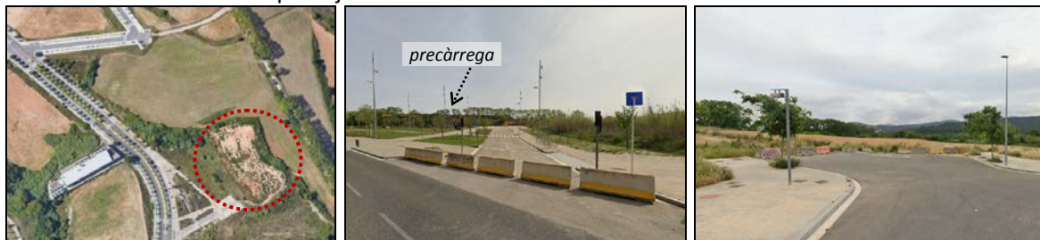
Vista aèria de la zona amb precàrrega i vista de estat actual des dels Eixos G i 3b
