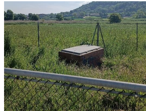
Imatge 1: Exterior de l'arqueta del pou.
