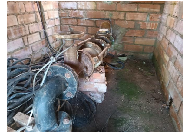
Imatge 2: Interior de la caseta del pou
