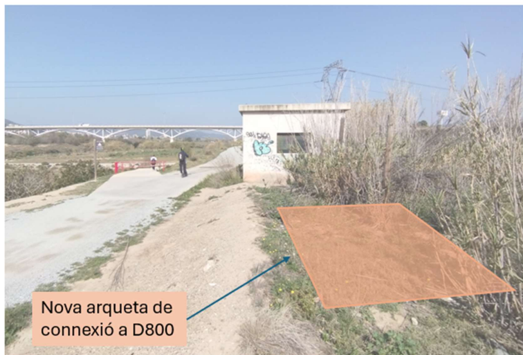
Fotografia 1: Emplaçament de la nova arqueta de connexió
