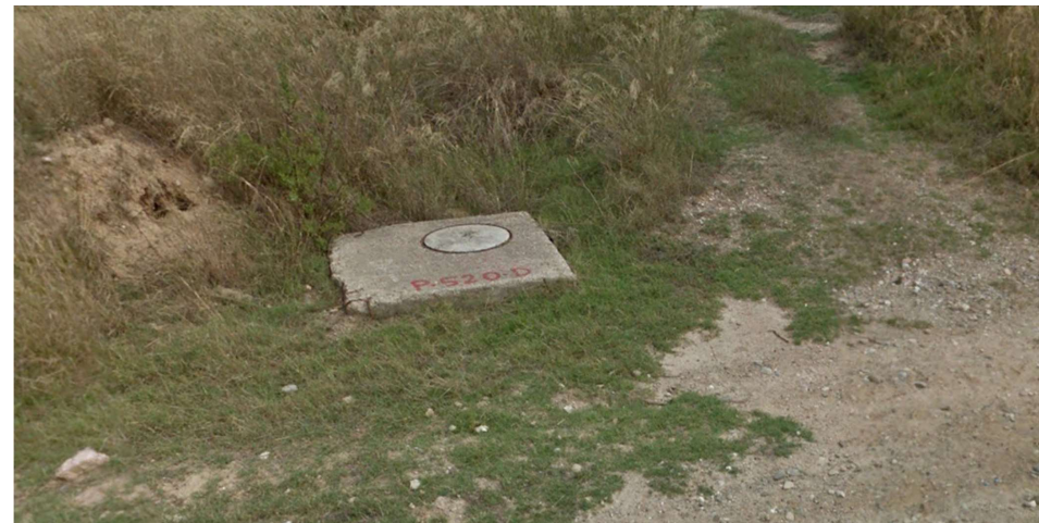
Fotografia 2: Col·lector de Salmorres (a confirmar) entre nova arqueta de connexió a D800 i pont
