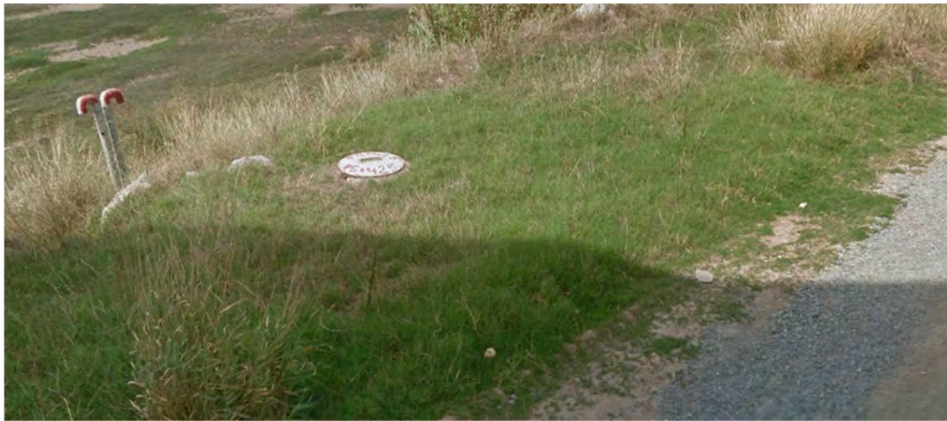
Fotografia 8: Col·lector de Salmorres (a confirmar), en talús, entre pont i aiguamolls
