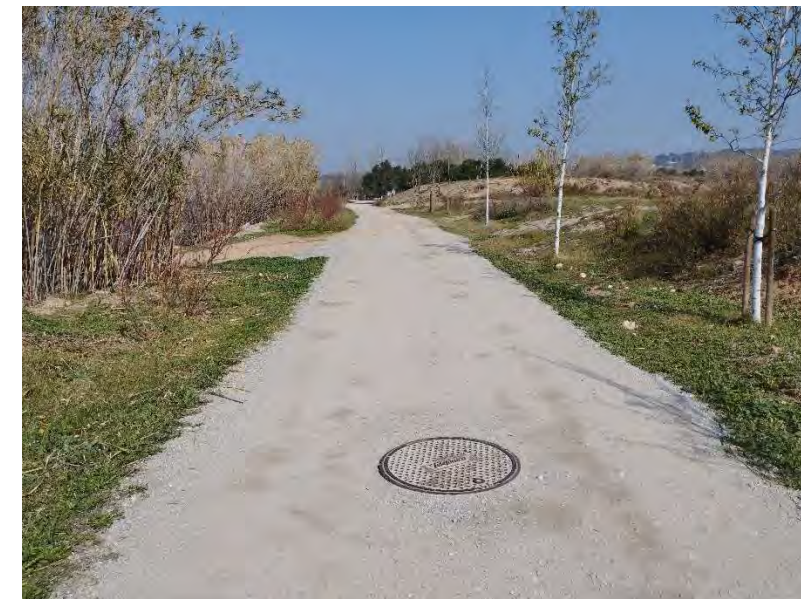
Fotografia 5: Registre amb inscripció de Telefonica, entre pont i aiguamolls
