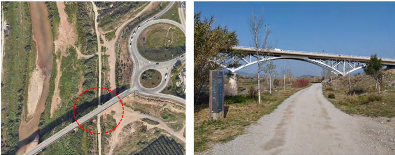
Fotografia 1: Detall pas sota pont d'unió B-23 i A-2
