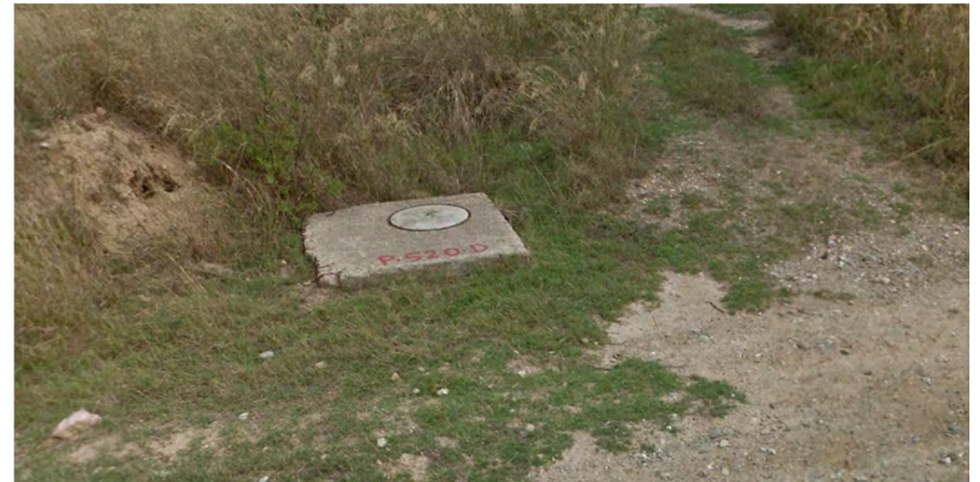
Fotografia 6: Col·lector de Salmorres (a confirmar) entre nova arqueta de connexió a D800 i pont
