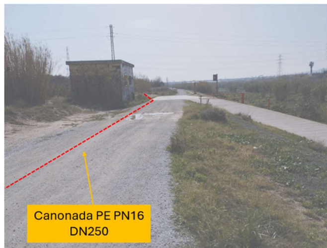
Fotografia 3: Traçat de la nova canonada (representació aproximada).
