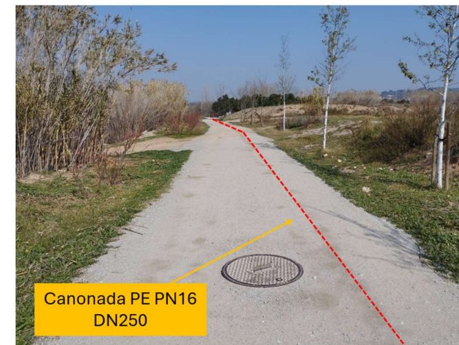
Fotografia 4: Traçat de la nova canonada i arqueta de desguàs a l'aiguamoll (representació aproximada).
