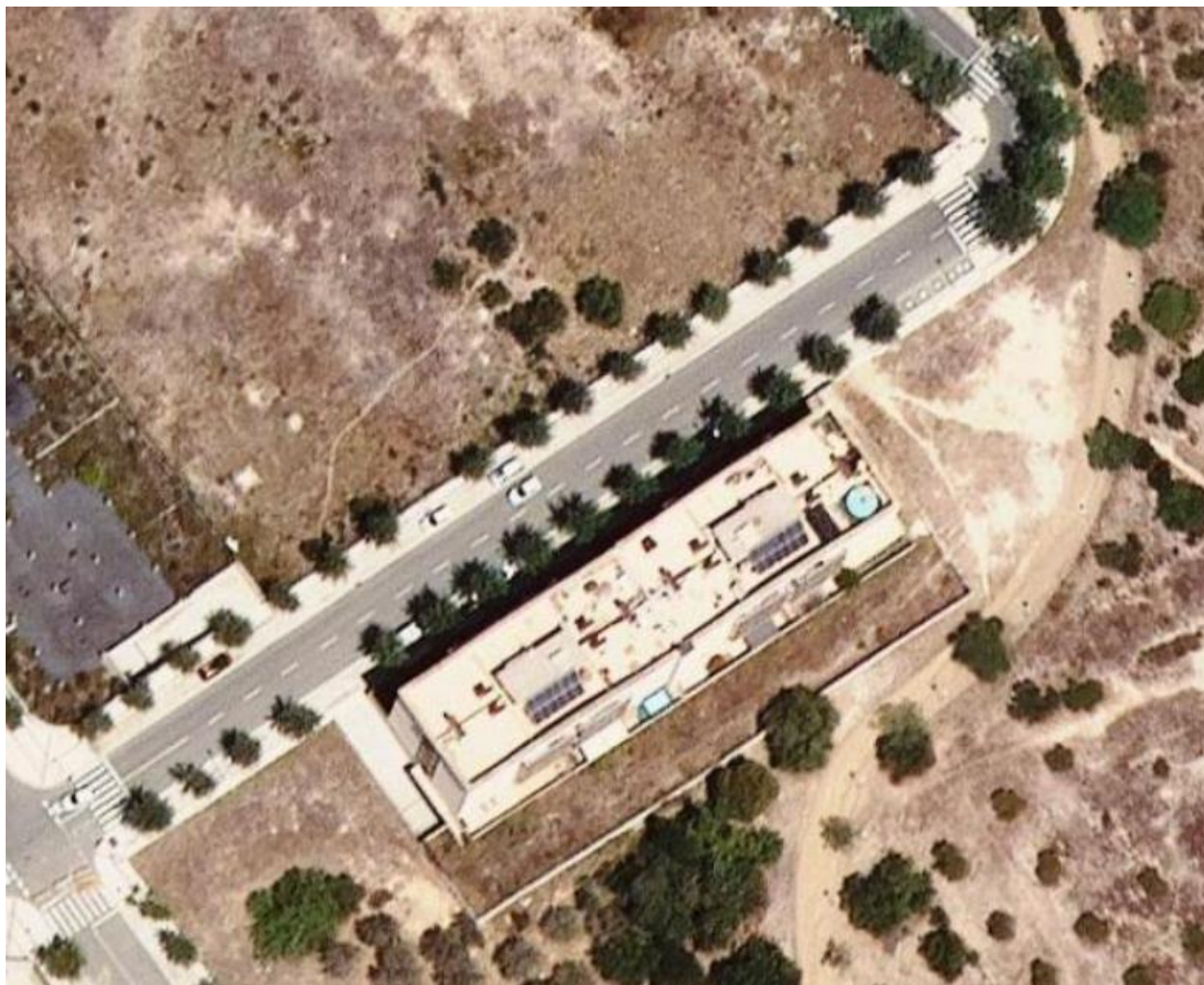
TRAM 2.- Carrer Flix ( Intersecció amb c/ de la Coma i Jaume I) I
