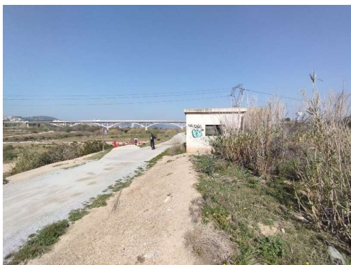
Fotografia 6: Mota de terres i caseta del sífó
