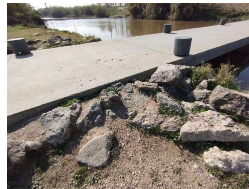
Fotografia 27: Detall d'escullera
