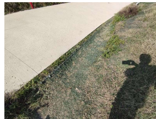
Fotografia 11: Detall paviment i geomalla
