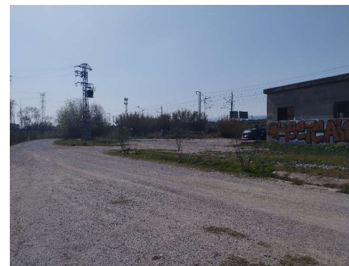
Fotografia 40: Vista general, a la dreta caseta del sífó
