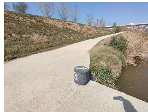
Fotografia 31: Vista del camí lateral al marge dret
