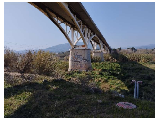
Fotografia 19: Vista de la llera del riu i serveis existents
