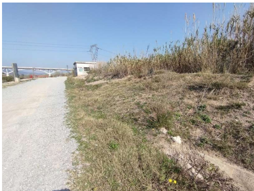
Fotografia 5: Vista del camí, mota i a fons caseta del sífó
