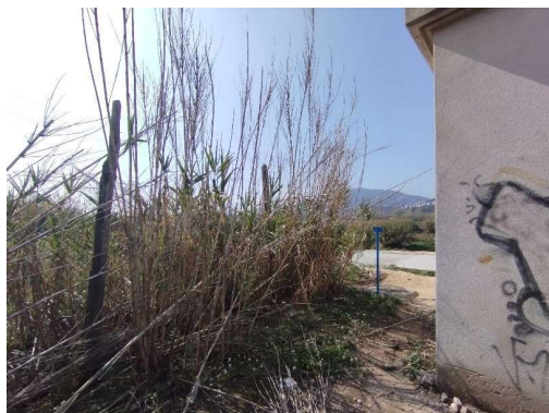
Fotografia 9: Vista arqueta de vàlvula de ventosa i element senyalitzador
