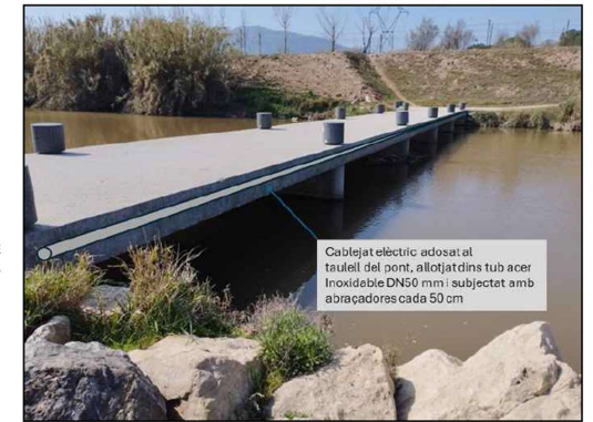
Figura 4: Alternativa 1. Connexió a xarxa elèctrica al marge dret. Detall canonada adosada al pont
