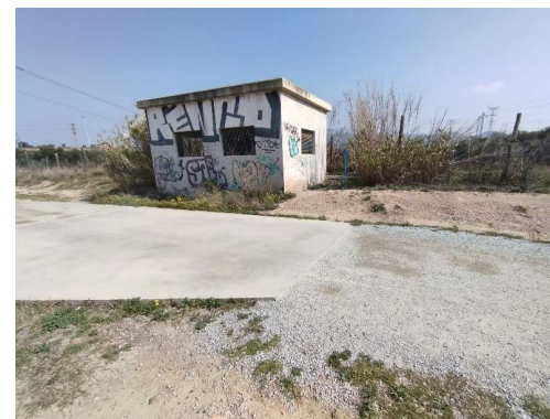
Fotografia 8: Detall pavimentacions i caseta del sífó
