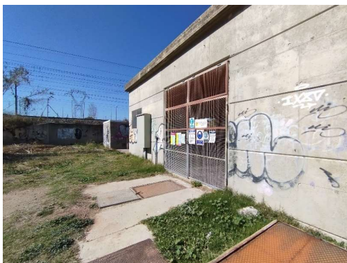
Fotografia 42: Lateral de la caseta del sífó
