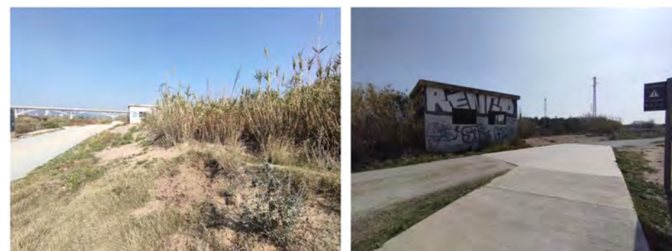
Fotografia 4: Vista zona per on trancorre la canonada D800 (de l'ERA) i caseta del sífó (marge esquerre)
