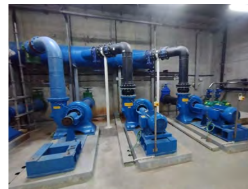
Fotografia 3: Instal·lacions d'impulsió de les aigües tractades a l'EDAR Sant Feliu de Llobregat
