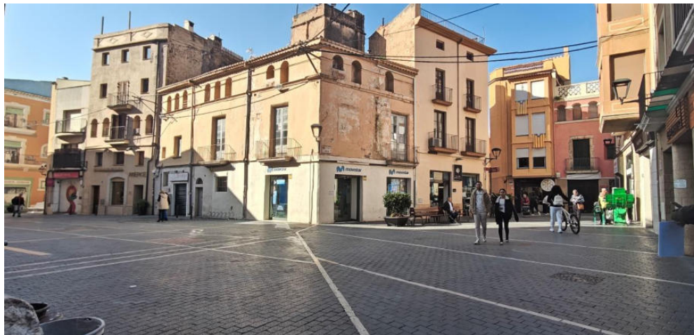
FOTO-04 - Vista General plaça i línies a retirar
