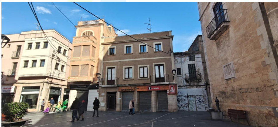
FOTO-03 - Vista General plaça i línies a retirar
