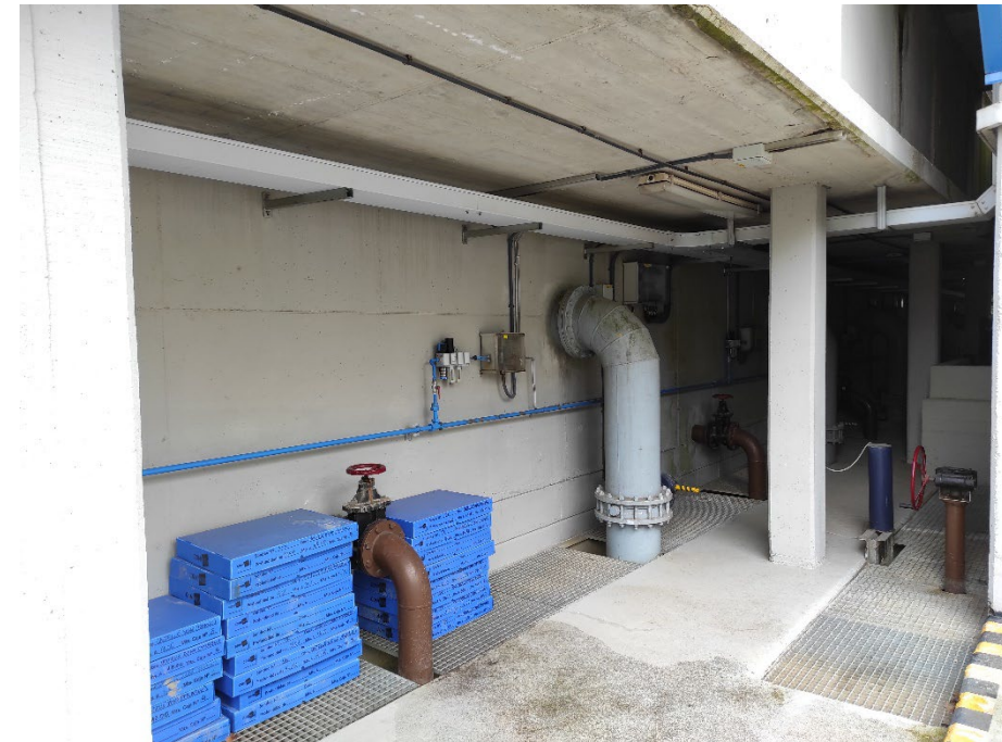
Fotografia 2. Vàlvules de sortida dels filtres
