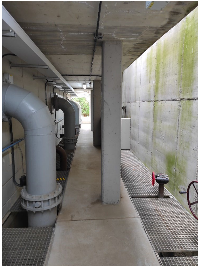
Fotografia 4. Vàlvules de sortida dels filtres
