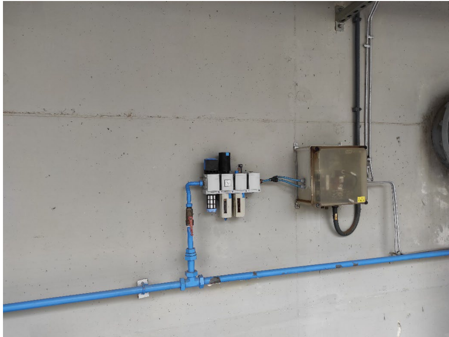
Fotografia 8. Sistema pneumàtic de les vàlvules de sortida dels filtres
