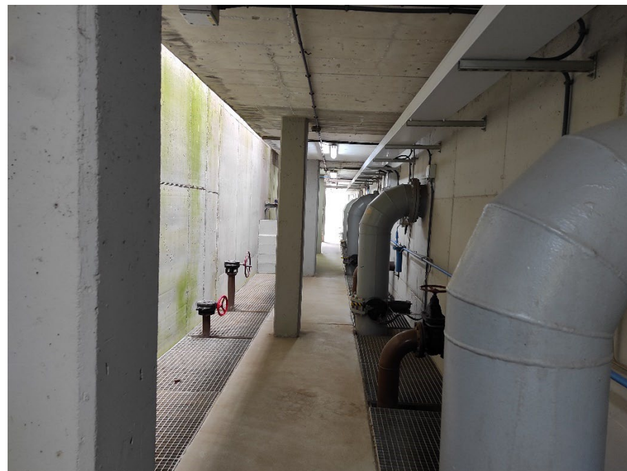
Fotografia 5. Vàlvules de sortida dels filtres
