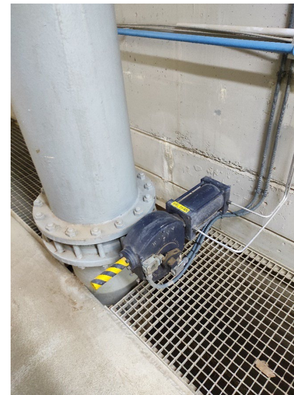
Fotografia 7. Vàlvules de sortida dels filtres
