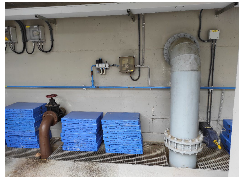
Fotografia 3. Vàlvules de sortida dels filtres
