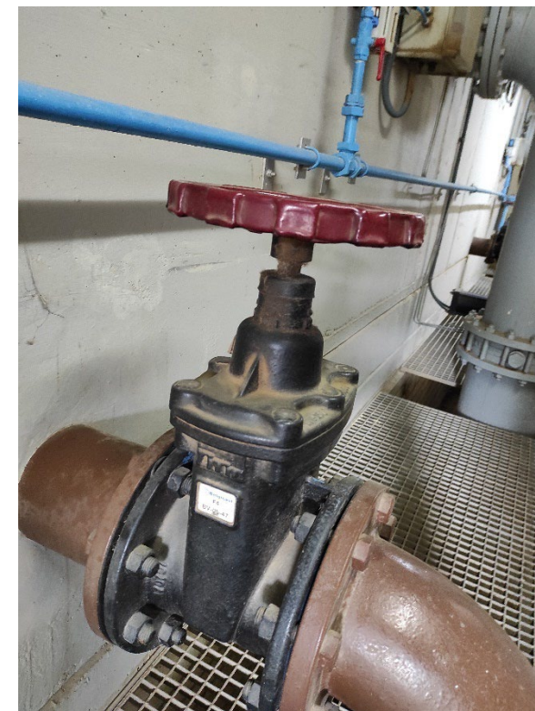
Fotografia 11. Vàlvules de sortida dels filtres
