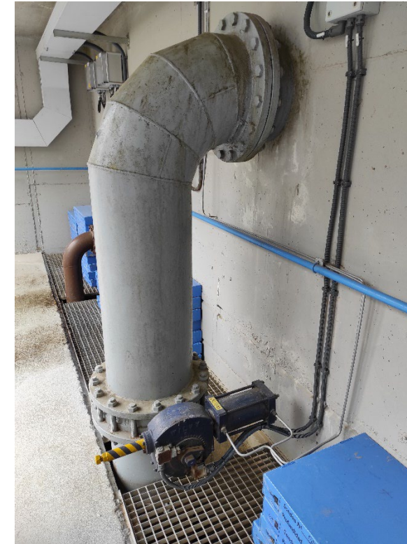
Fotografia 6. Vàlvules de sortida dels filtres
