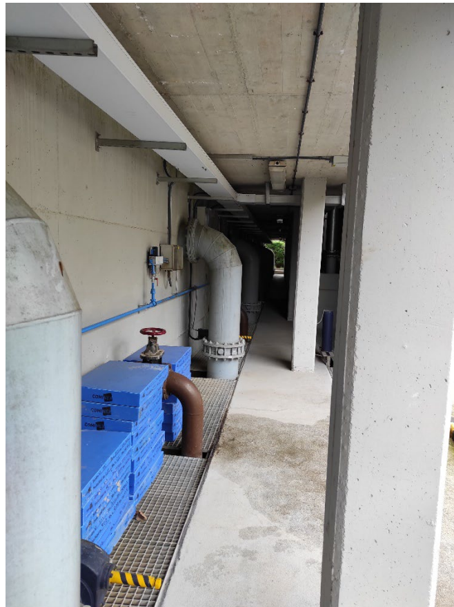
Fotografia 1. Vàlvules de sortida dels filtres
