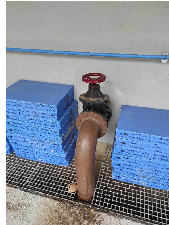
Fotografia 10. Vàlvules de sortida dels filtres
