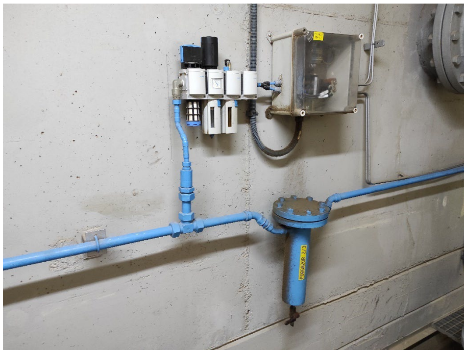
Fotografia 9. Sistema pneumàtic de les vàlvules de sortida dels filtres
