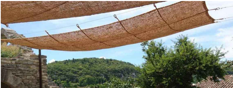
DETALL DE SISTEMA DE FIXACIÓ AL CABLE AMB MOSQUETÓ, ULLARS I CORDES DE REFORÇ EN QUADRÍCULA
