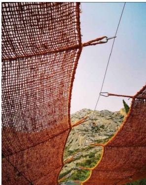
DETALL DE SISTEMA DE FIXACIÓ AL CABLE AMB MOSQUETÓ, ULLARS I CORDES DE REFORÇ EN QUADRÍCULA
