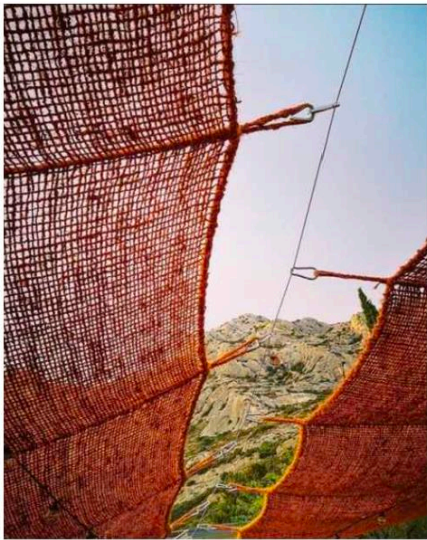
DETALL DE SISTEMA DE FIXACIÓ AL CABLE AMB MOSQUETÓ, ULLARS I CORDES DE REFORÇ EN QUADRICULA
