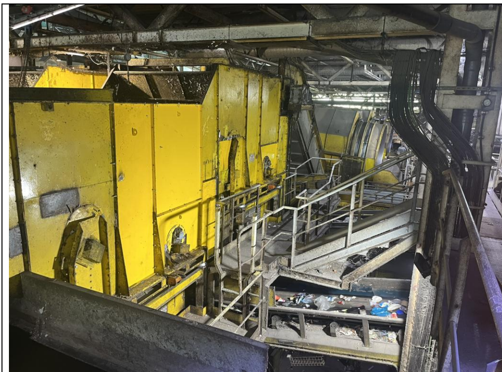
Escales i passarel·les d'accés.
