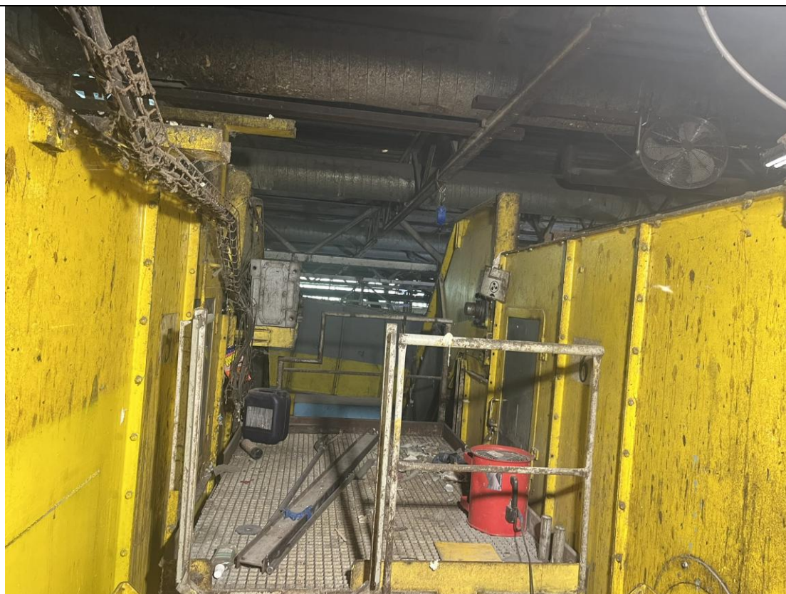
Accés pel manteniment als ST 2000
