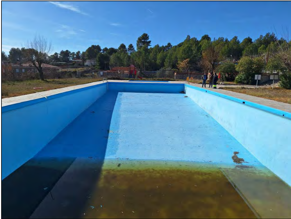
Figura núm. 6 Piscina i entorn. Piscina gran
