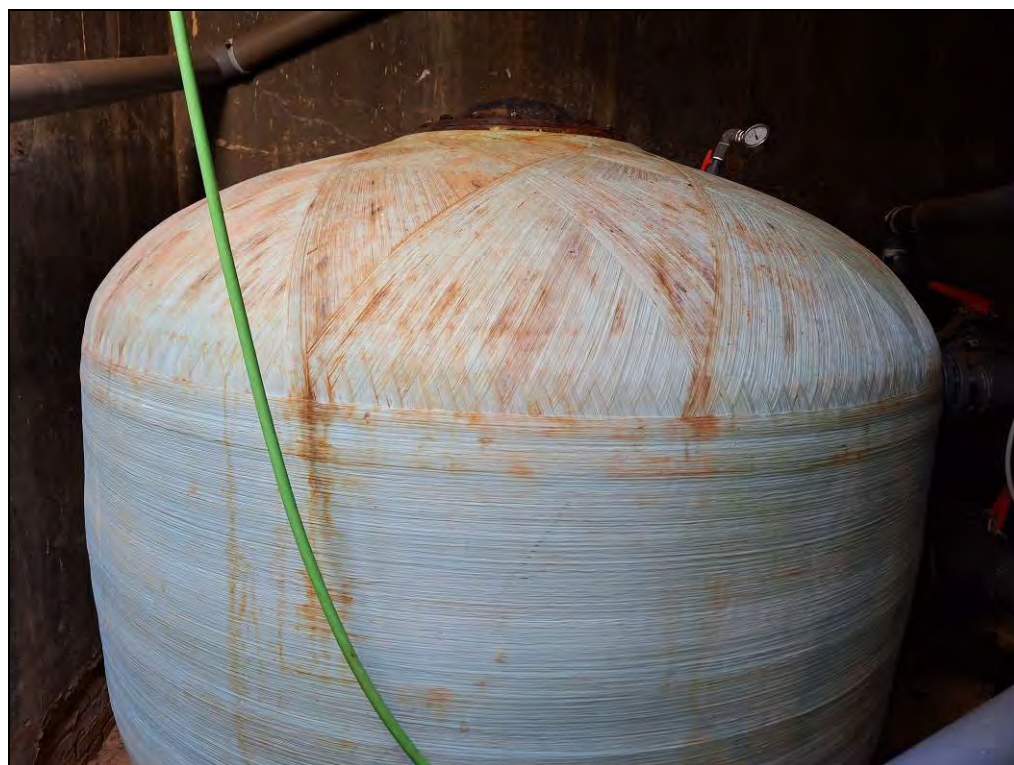
Figura núm. 8 Caseta d'instal·lacions. Estat actual filtre
