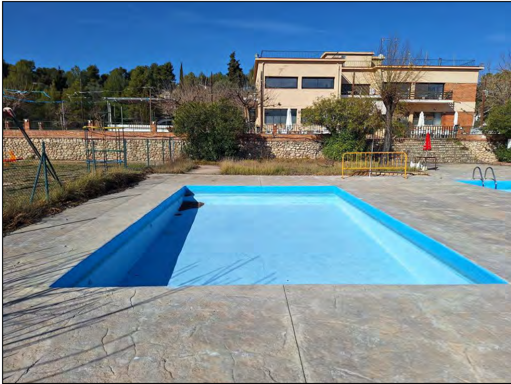
Figura núm. 5 Piscina i entorn. Piscina petita
