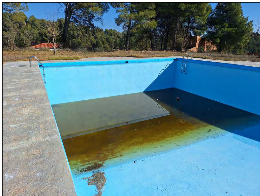
Figura núm. 7 Piscina i entorn. Piscina gran. Zona de major fondària.
