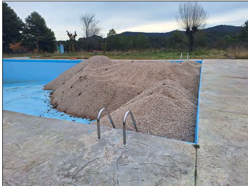
Figura núm. 11 Graves col·locades al interior de la piscina gran per rasantejar.
