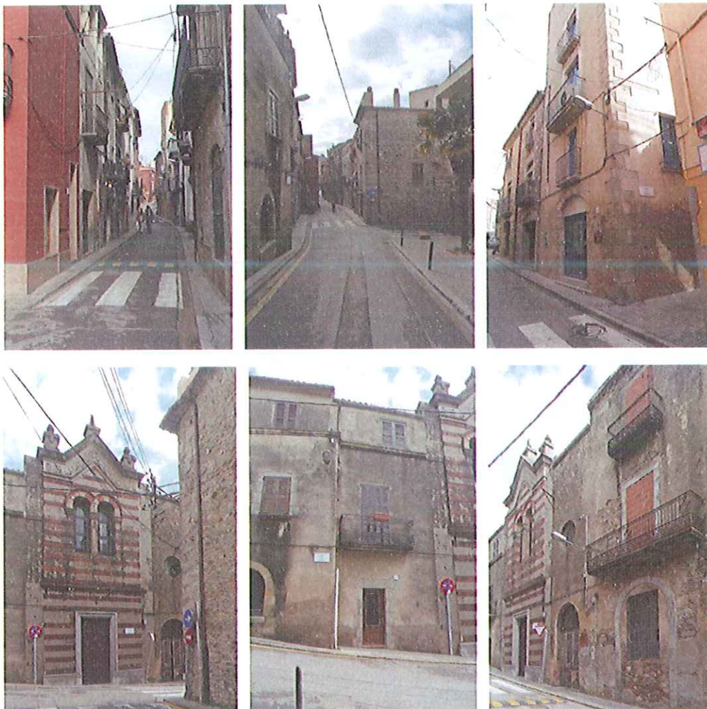
DOCUMENTACIÓ FOTOGRÀFICA: ESTAT DE CONSERVACIÓ, ELEMENTS D'INTERÈS
