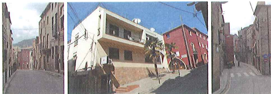
DOCUMENTACIÓ FOTOGRÀFICA: ESTAT DE CONSERVACIÓ, ELEMENTS D'INTERÈS
