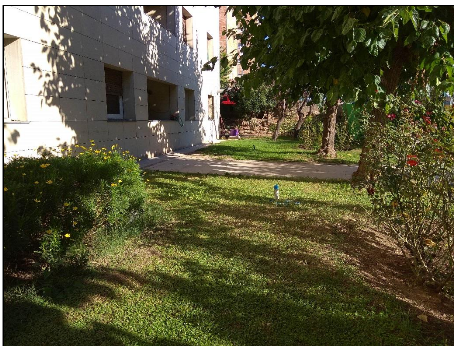
Aspecte del solar estudiat. Rasant de la planta semisoterrani actual.
