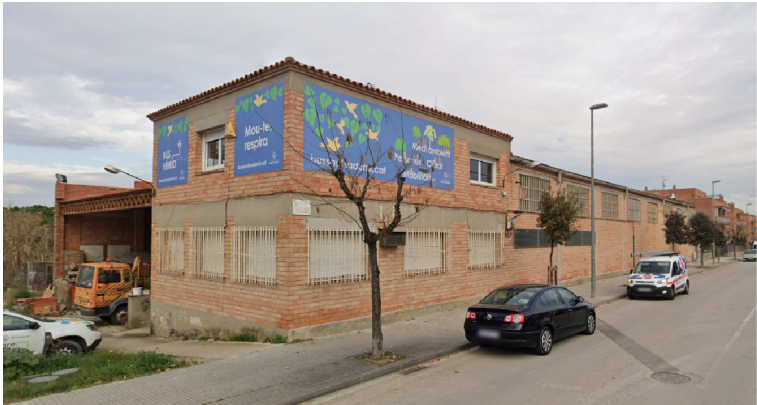
Imatges edifici magatzem brigada municipal.
