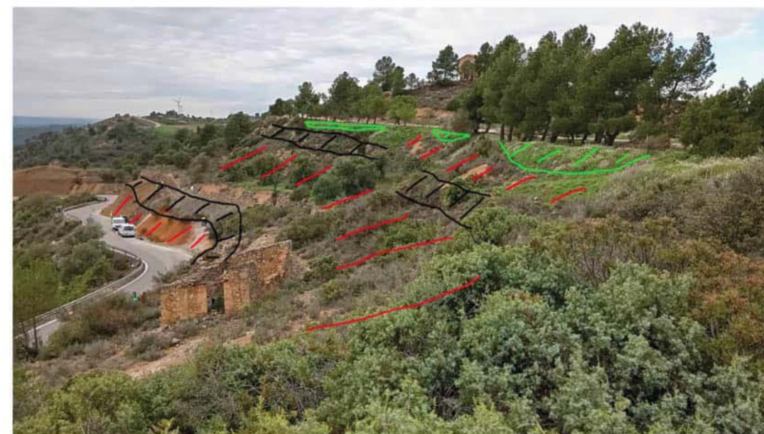
Es destaquen en el vessant les unitats rocoses formades per conglomerats, gresos i margo-calcàries (trama negra), unitats de lutites i margues (trama vermella), i reblerts de materials aportats en cap de talús (en verd).
