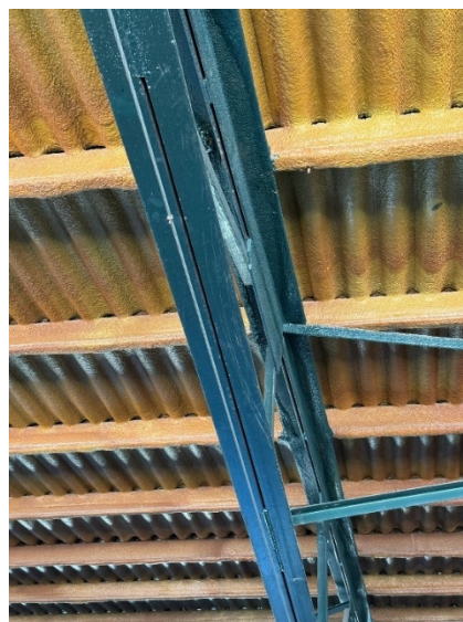
Encavallada i coberta
