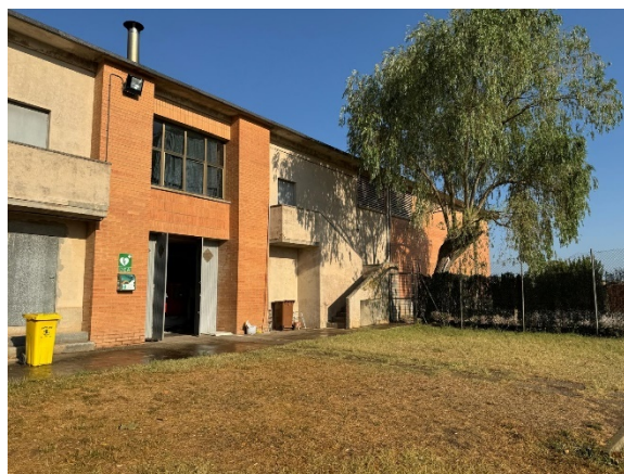
Accessos façana est
