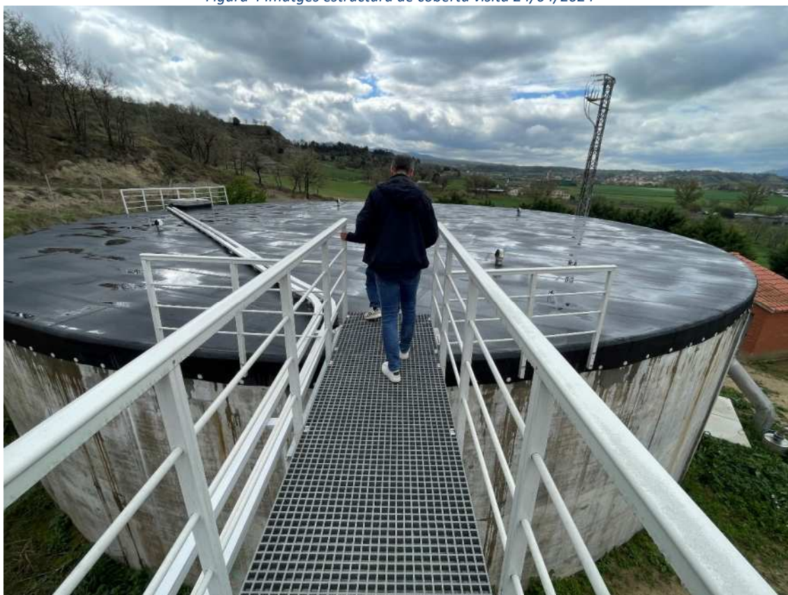
Figura 5 Imatges estructura de coberta visita 24/04/2024
