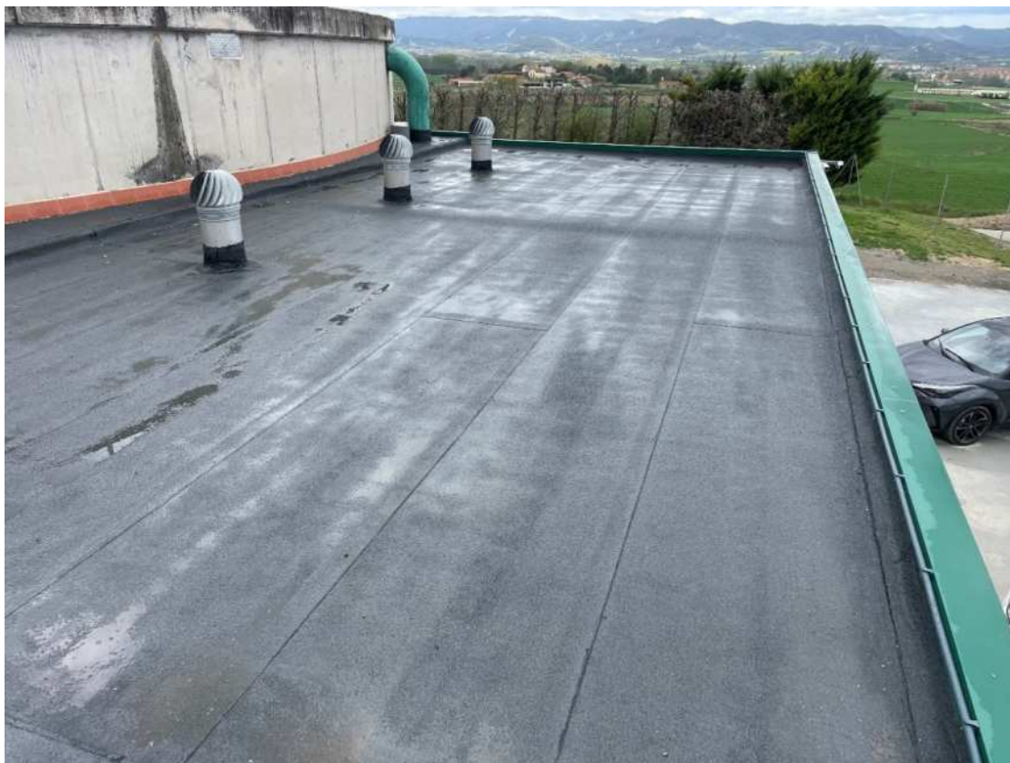
Figura 2 Imatges estructura de coberta visita 24/04/2024
