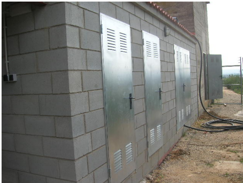
Fotografia núm. 8. Casetes annexes al dipòsit de Sils
