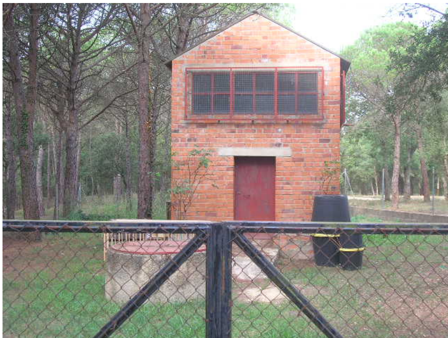
Fotografia núm. 3. Caseta captació de l'Urbanització de King Park
