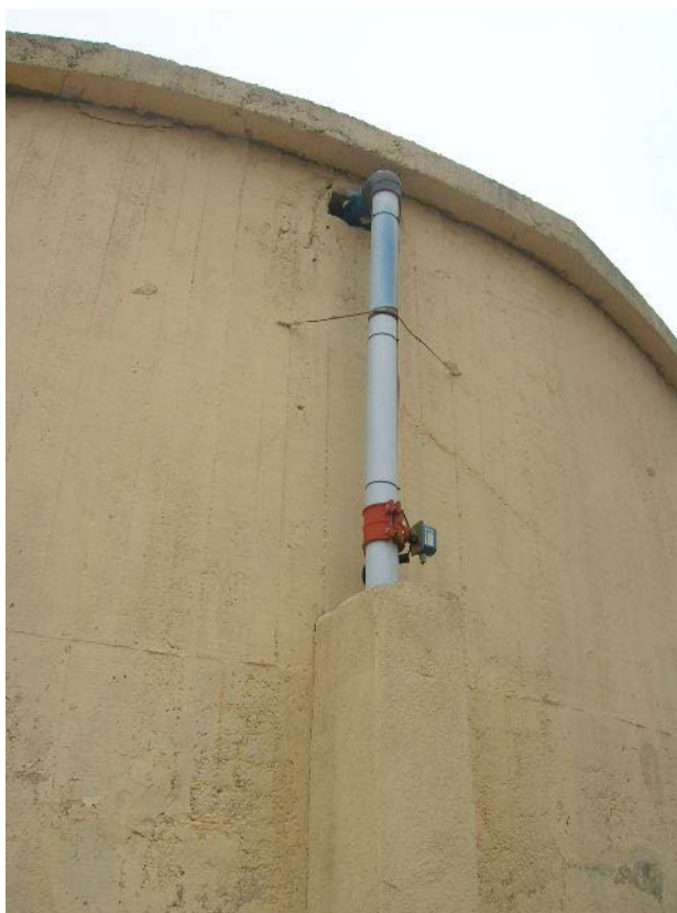
Fotografia núm. 6. Contador a entrada de dipòsit de Les Comes
