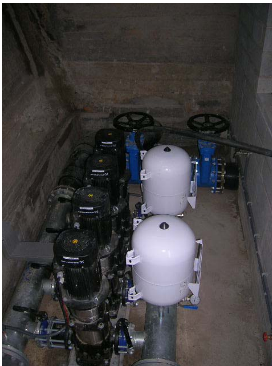
Fotografia núm. 17. Grup de pressió del dipòsit de Sils
