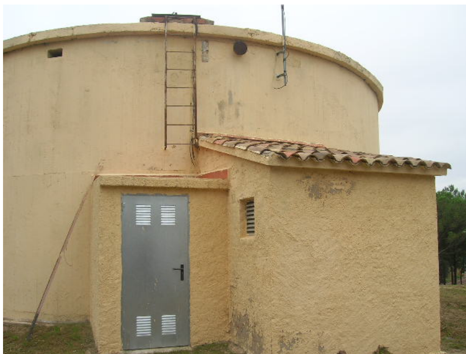
Fotografia núm. 7. Dipòsit de Les Comes i casetes annexes on es situen el sistema de cloració i el grup de pressió
