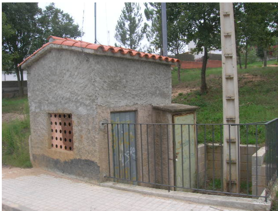
Fotografia núm. 3. Caseta de captació de Les Comes
