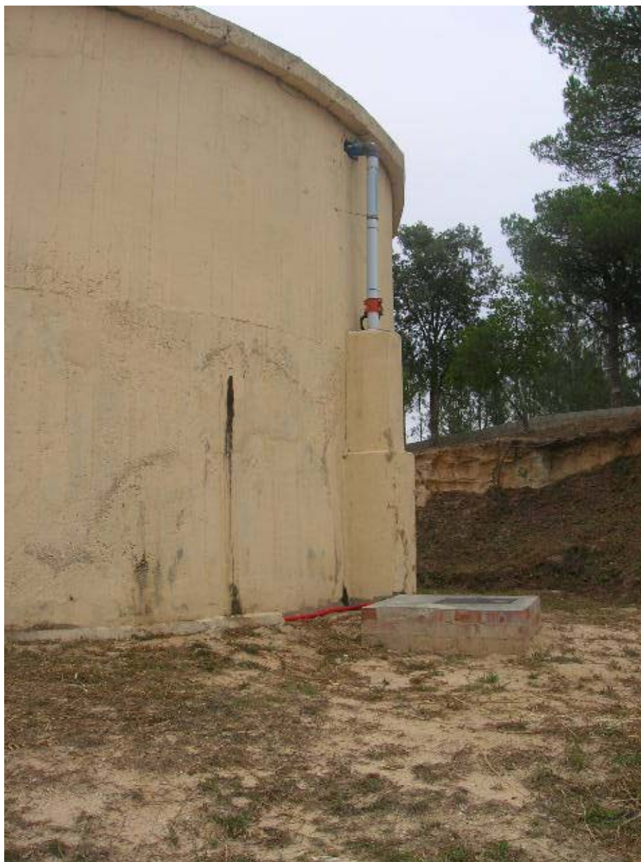
Fotografia núm. 5. Dipòsit de l'urbanització Les Comes
