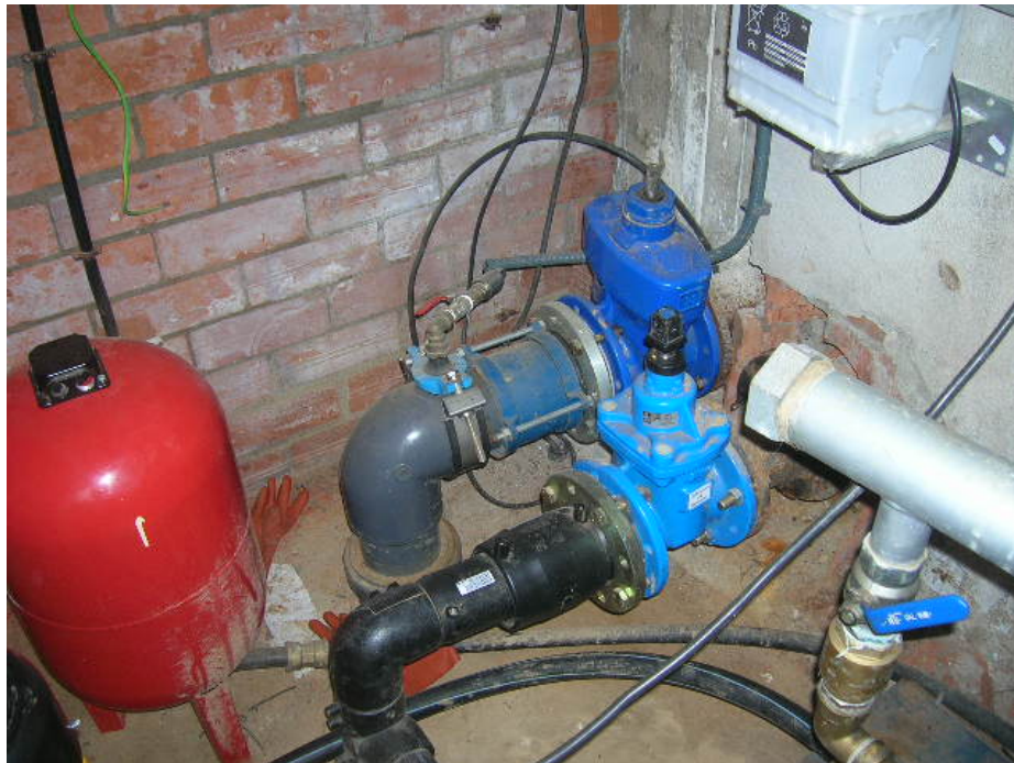
Fotografia núm. 11. Canonada de sortida de distribució de la xarxa de Les Comes
