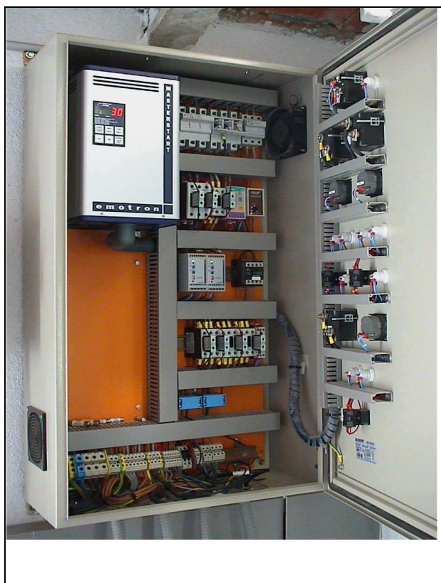
Exemple d'un arrencador progressiu de 40 CV
