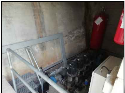
CASETA DE BOMBAMENT
