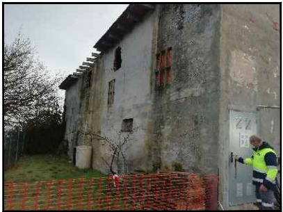
EDIFICI A ENDERROCAR
