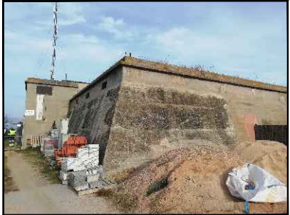
FAÇANA LATERAL DEL DIPÒSIT
