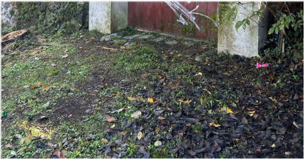
FOTOGRAFIA ACTUAL DEL NOU EMPLAÇAMENT - PAVIMENT D'ACCÉS A ÀMBIT D'OFICINES
