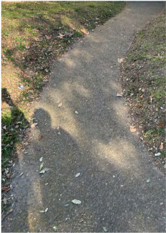
FOTOGRAFIA DEL PAVIMENT DE FORMIGÓ AMB ÀRID BASÀLTIC EXISTENTE AL LLOC
