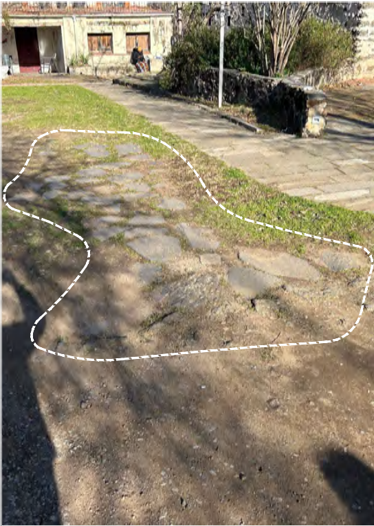
FOTOGRAFIA ACTUAL DE LES PEDRES AL LLOC, QUE S'HAN D'AIXECAR I RECOL·LOCAR
