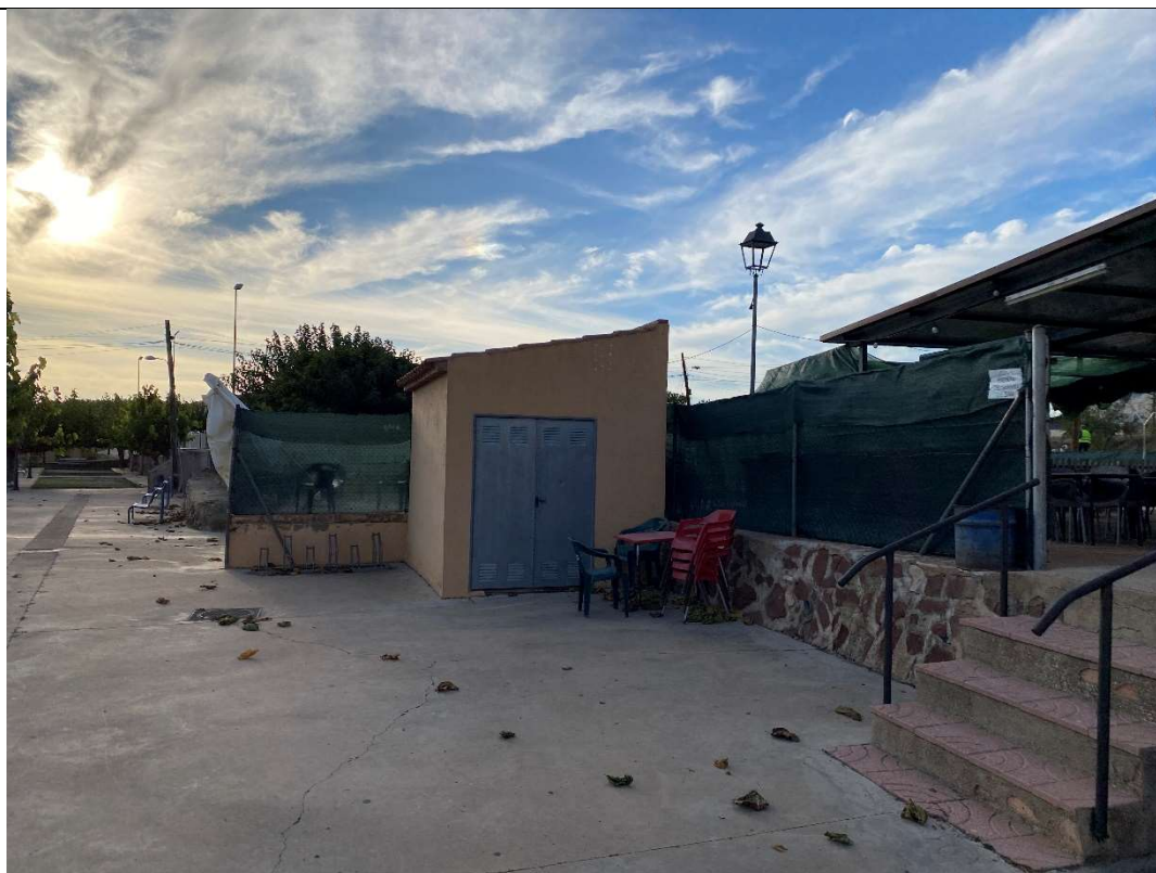
Fotografia 5. Zona instal·lacions caseta exterior – Carretera Mora 2
