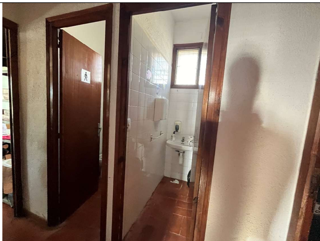
Fotografia 14. Interior edifici existent (banys) – Carretera Mora 2.
