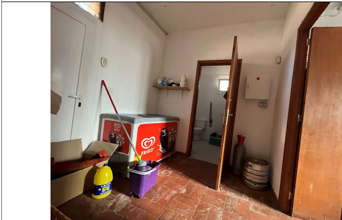
Fotografia 16. Interior edifici existent – Carretera Mora 2
