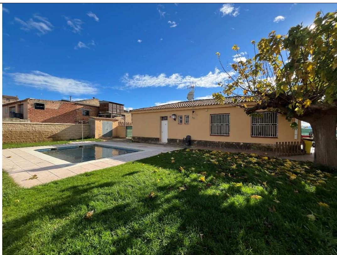
Fotografia 8. Façana posterior edifici existent i piscina petita – Carretera Mora 2
