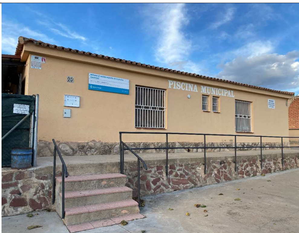
Fotografia 2. Façana principal edifici existent – Carretera Mora 2
