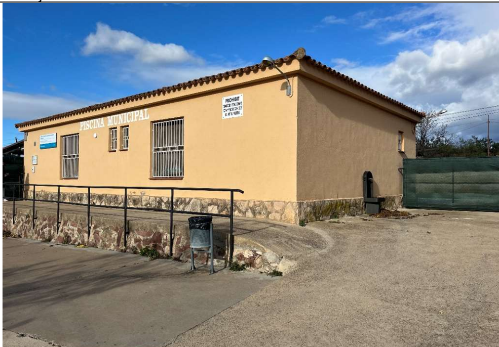
Fotografia 1. Façana principal edifici existent – Carretera Mora 2
