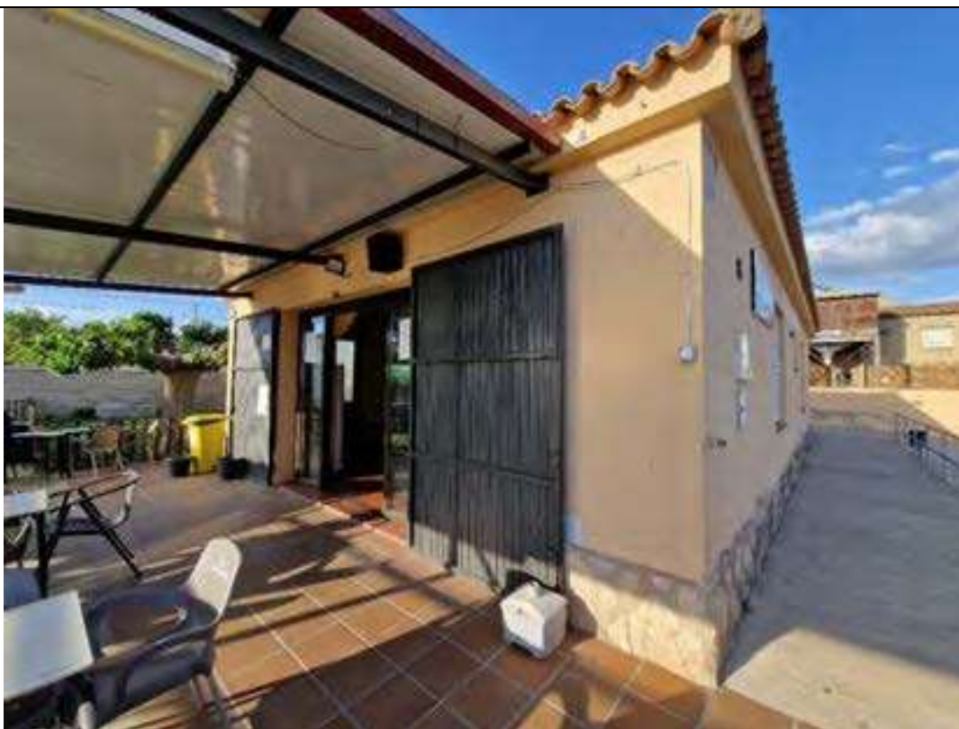
Fotografia 6. Accés principal a edifici existent – Carretera Mora 2
