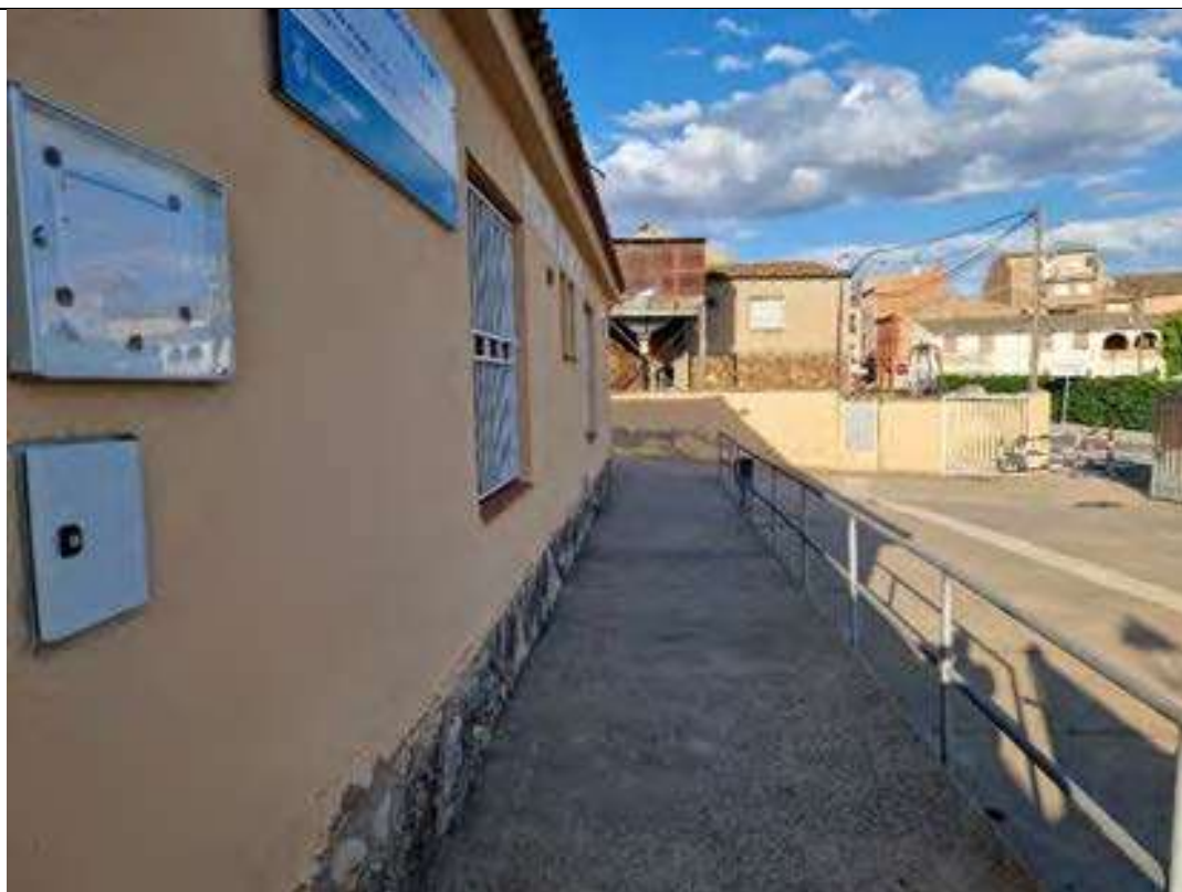
Fotografia 3. Accés existent a zona esportiva – Carretera Mora 2
