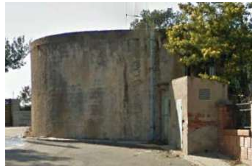
Figura 1. Vista exterior dipòsit Can Palau 3
