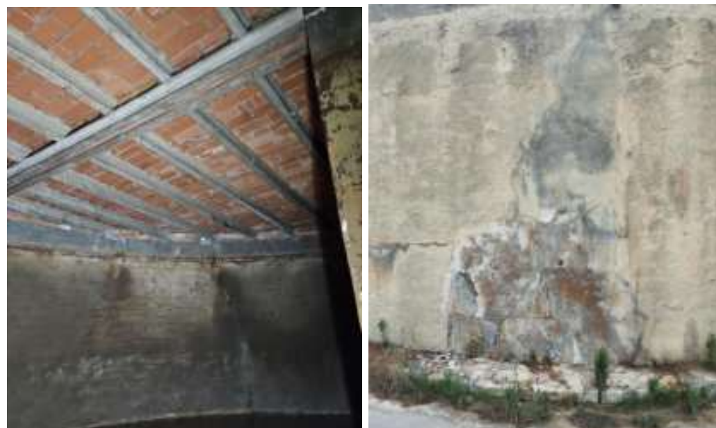
Figura 2. Vista interior i exterior dipòsit Can Palau 3
