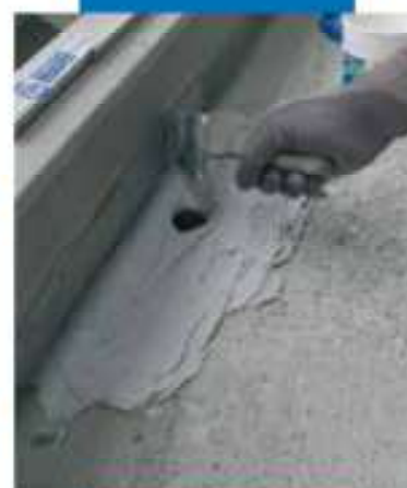
Cobertura final con Adesilex PG4
