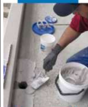
Extensión de Adesilex PG4 mediante paleta
