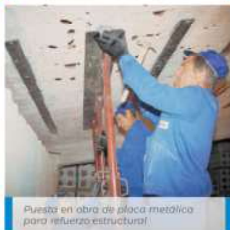
Viga placada con Adesilex PG1
