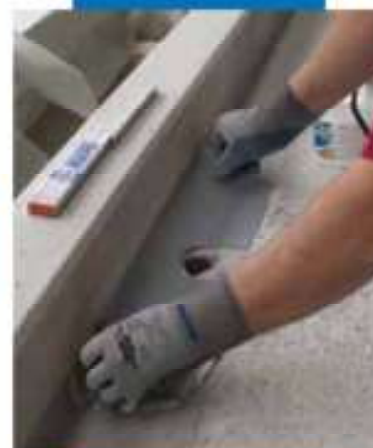
Colocación de banda clásica de Hypalon
