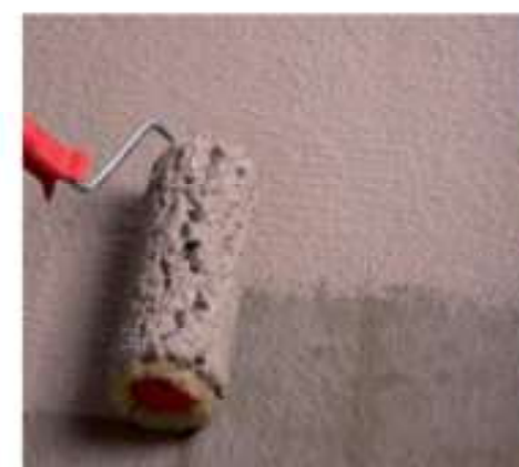
Impermeabilización a rodillo
