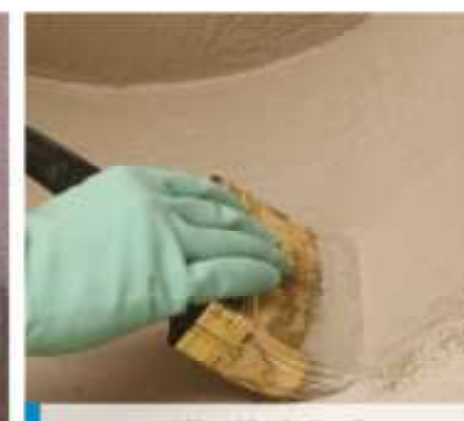
Impermeabilización de detalle a brocha
