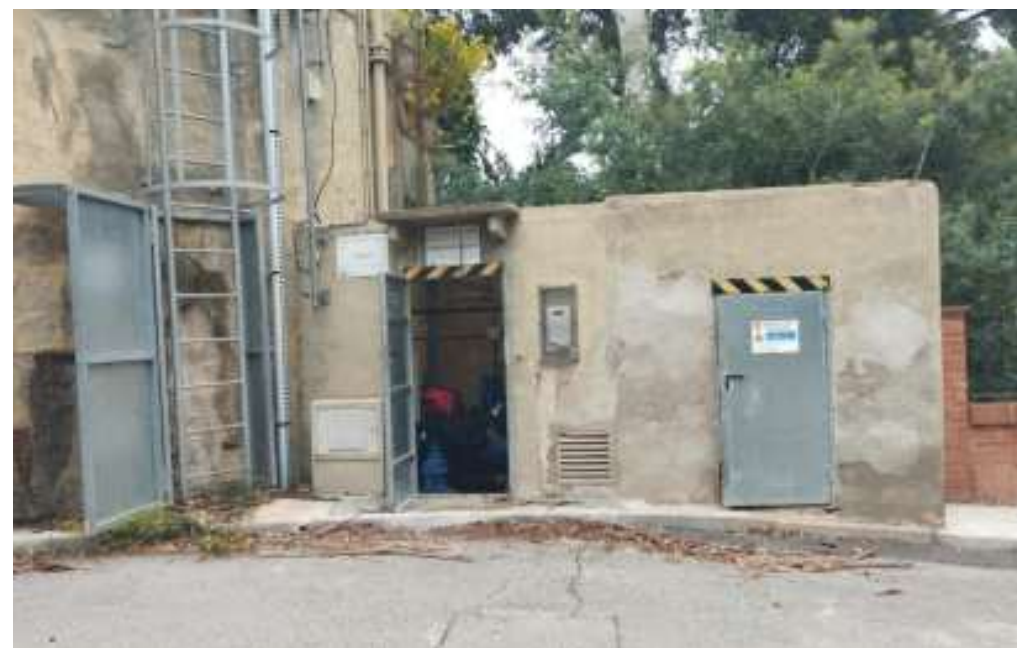
Figura 3. Vista exterior de la caseta de bombament
