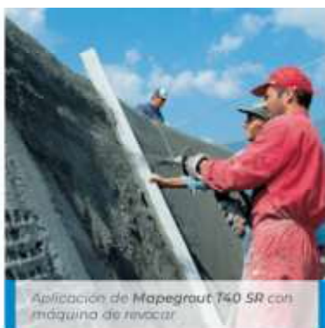
Acabado de Mapegrout T40 SR con frótis
