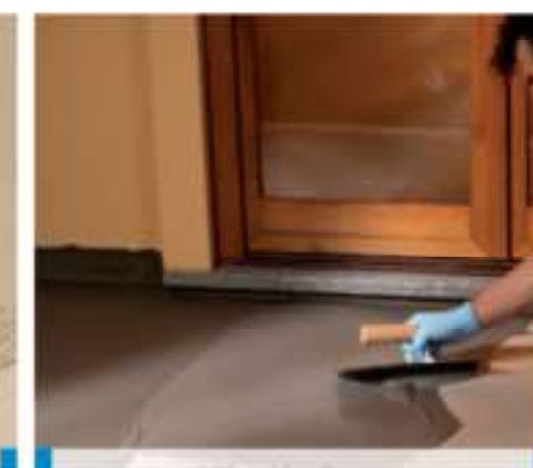
Impermeabilización de terraza con llana
