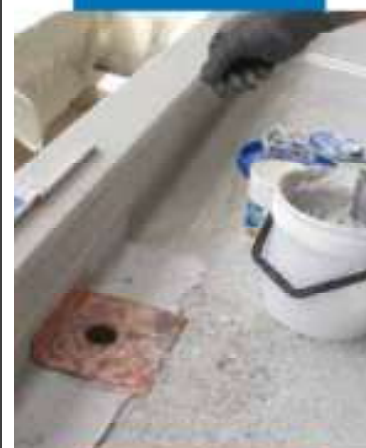
Colocación de collarín y sumidero de cobre
