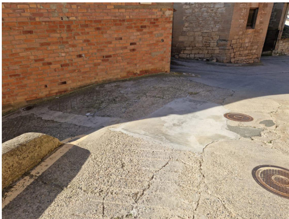
Situació del nou pou de registre, al punt final de l'actuació, on hi ha el canvi de direcció de la xarxa existent, davant del número 3 (les tapes existents són d'aigua potable)
