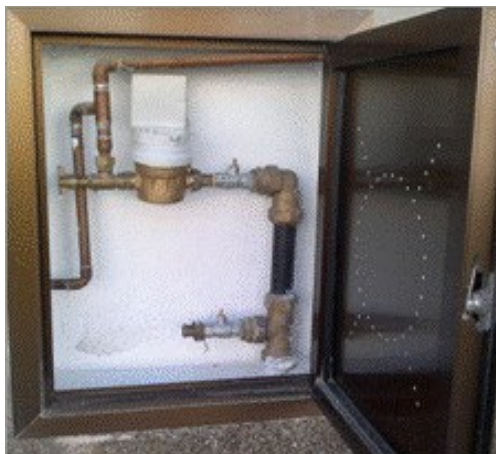
Exemples d'instal·lacions de comptador amb mòdul de teletectura incorporat
