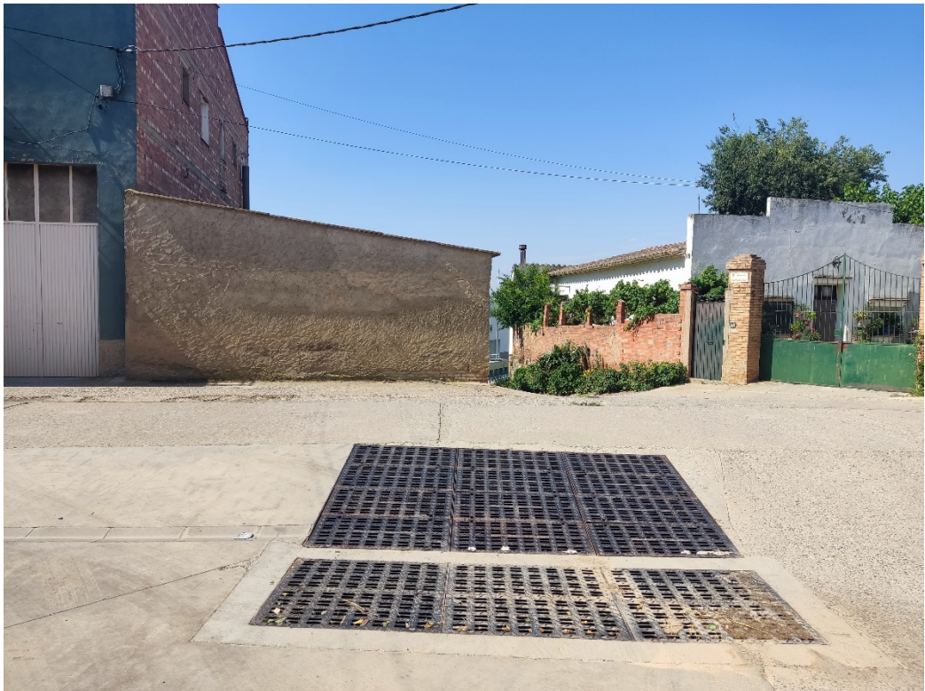
Fotografia 1. Reixa existent de recollida de pluvials; al fons esquerra, magatzem a enderrocar.
