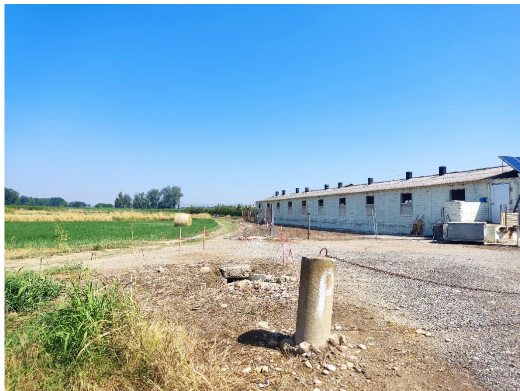
Fotografia 6. Tram en rústic, sota traçat tanca granja, pk 0+840 a 0+. Col·lector formigó armat DN1000.
