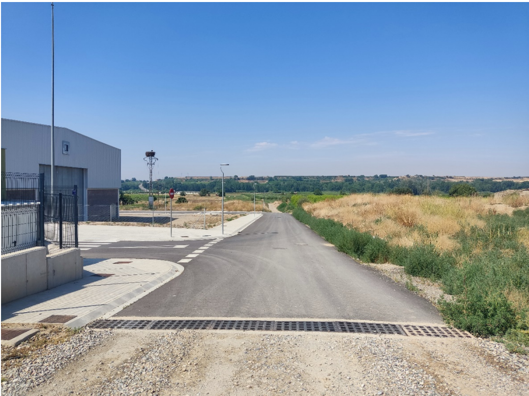
Fotografia 3. Tram urbà, Travessera carrer de la Creu, pk 0+075 a 0+157 m. Col·lector PEAD DN00 SN8.
