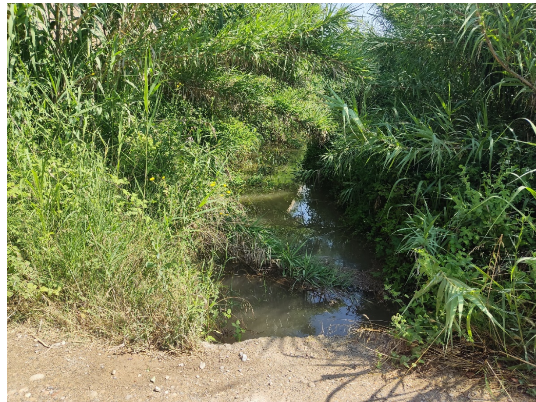
Fotografia 8. Punt de desguàs, pk 1+232. Col·lector PEAD DN1000 SN8.
