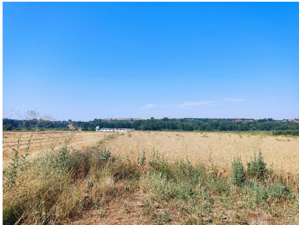
Fotografia 5. Tram en rústic, en terrenys cultivats, pk 0+550 a 0+735. Col·lector PEAD DN1000 SN8.
