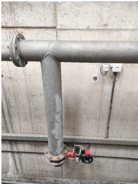
Fotografia 5. Vàlvules entrada aire rentat dels filtres
