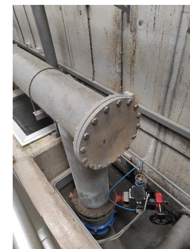
Figura 3. Actuadors en mal estat
