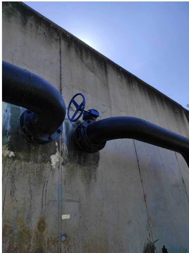
Fotografia 5. Vàlvules decantadors
