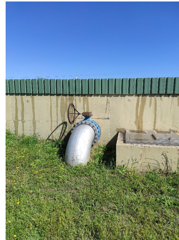
Fotografia 63. Arqueta connexió captació piscina i dipòsit nou
