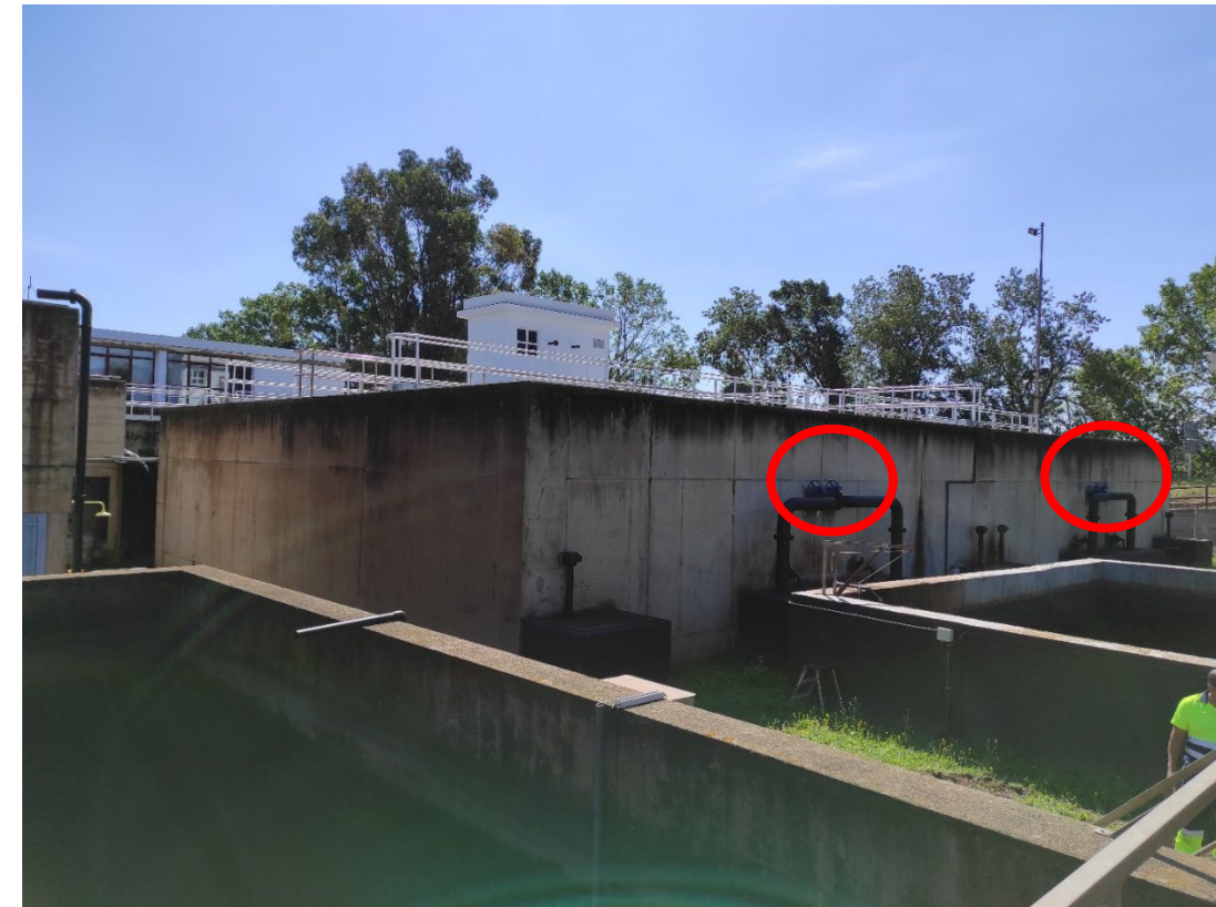
Figura 3. Vàlvules decantadors
