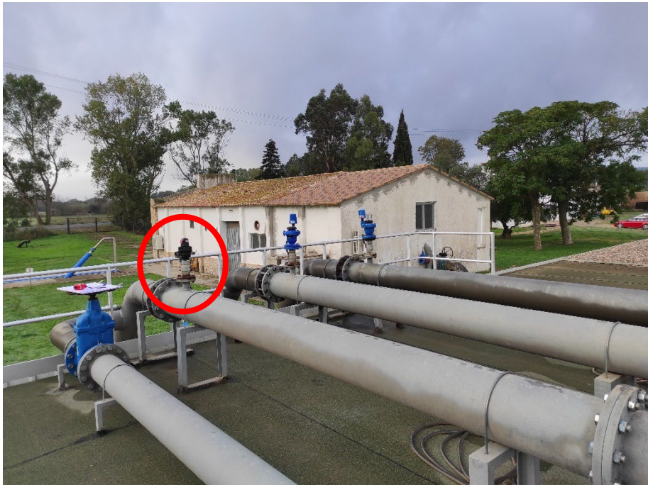
Figura 26. Vàlvula ventosa de la impulsió a dipòsit Quermany
