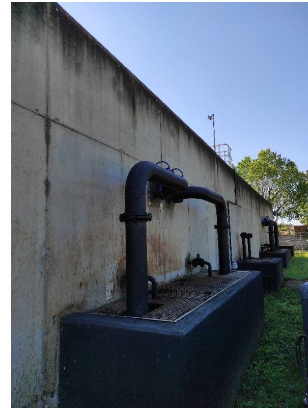
Fotografia 3. Vòlvules decantadors
