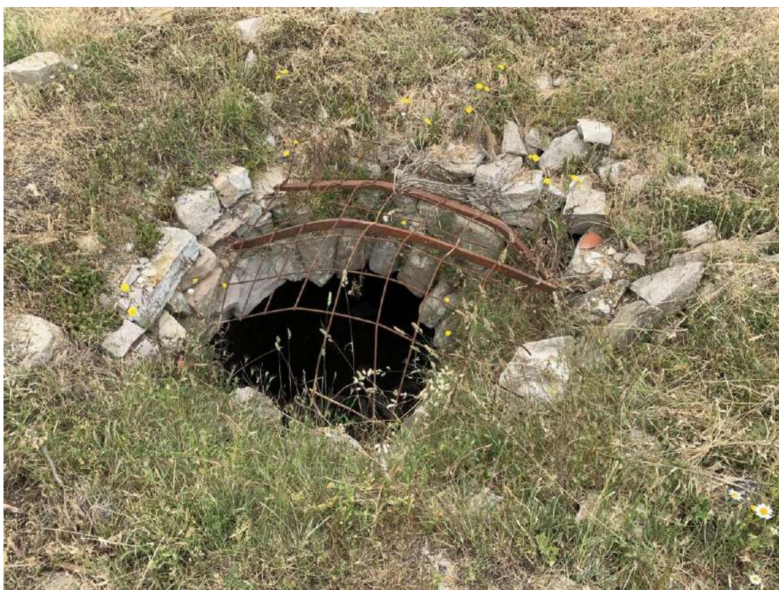
59.H Projecte Bàsic i d'Execució de restauració i consolidació parcial del castell d'Argençola. Etapes 2 i 3. Argençola (Anoia) RGD Arquitectura
