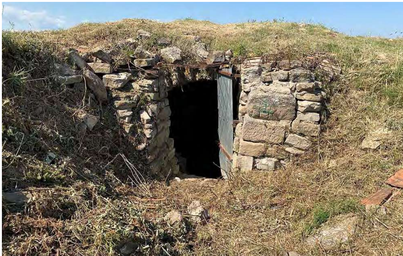
Fotografia de la zona a intervenir del castell d'Argençola, amb l'accés a l'espai cobert amb volta de pedra.
