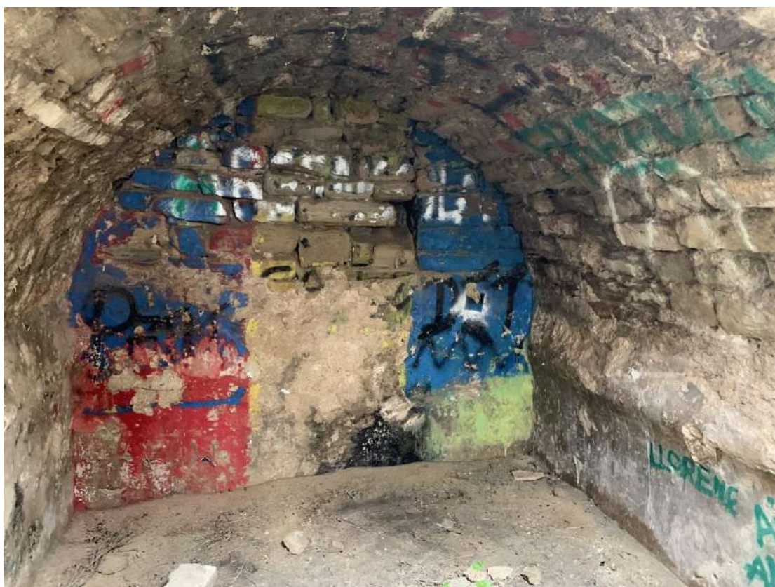
59.H Projecte Bàsic i d'Execució de restauració i consolidació parcial del castell d'Argençola. Etapes 2 i 3. Argençola (Anoia) RGD Arquitectura
