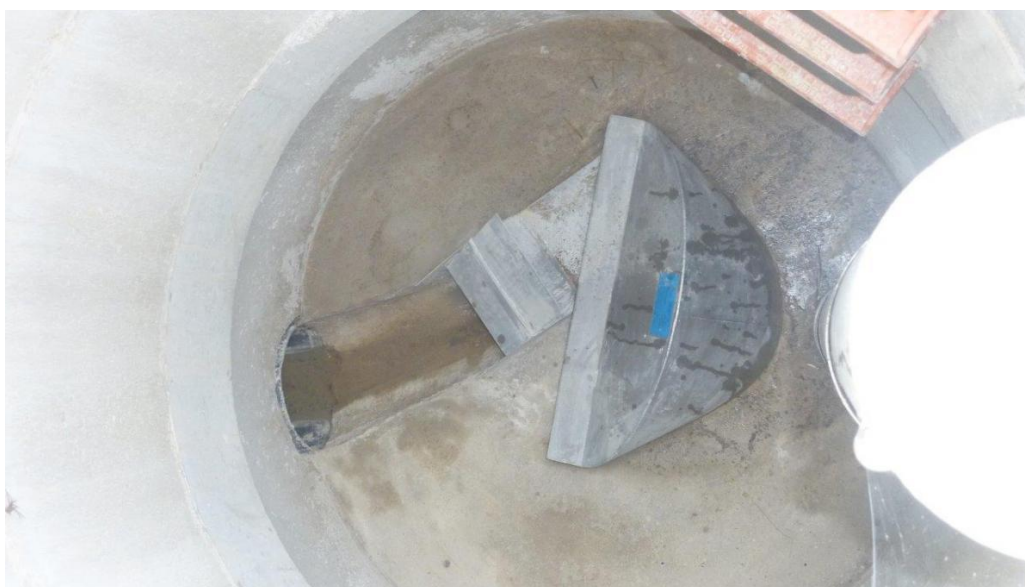
Figura 4: Exemple de vàlvula vòrtex en cambra humida
