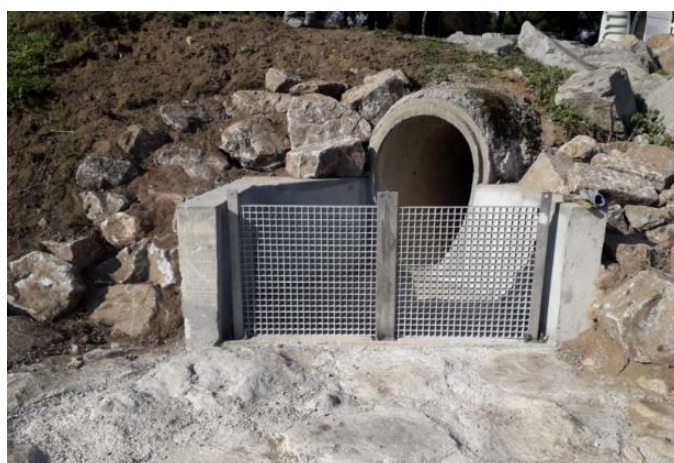
Figura 11 Exemple de sistema de retenció de sòlids
