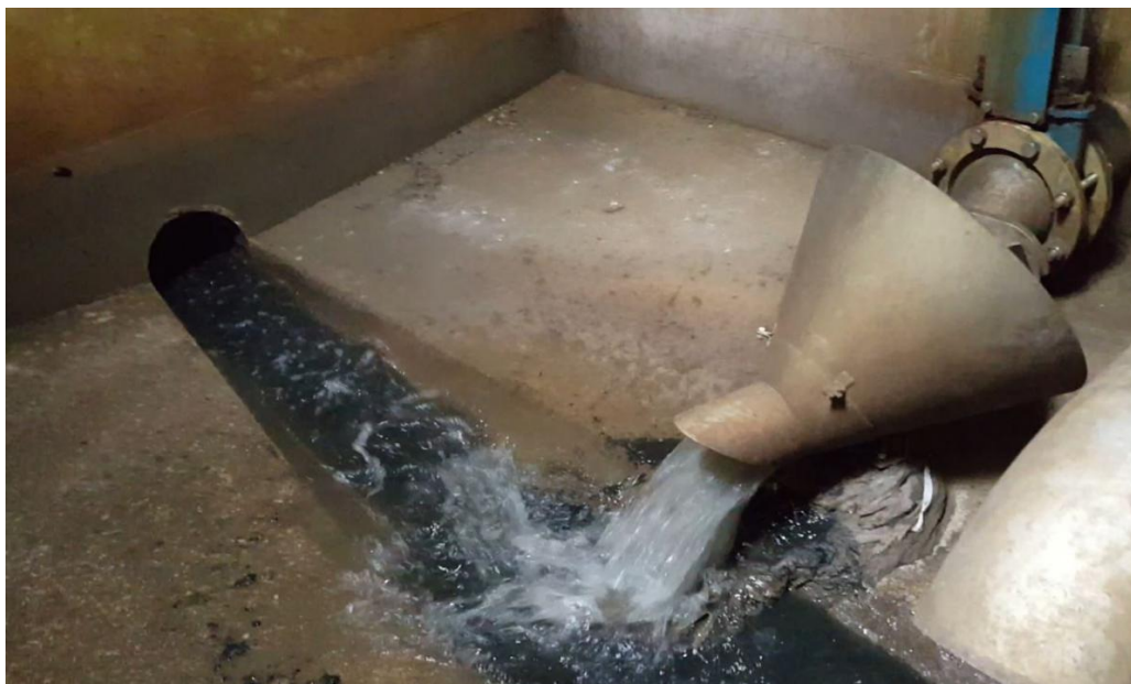
Figura 5: Exemple de vàlvula vòrtex en cambra seca
