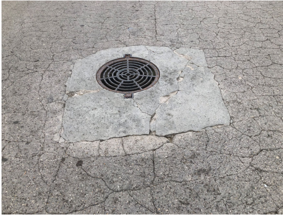
Flonjalls en tapes de clavegueram
