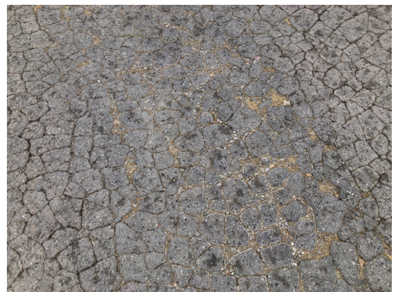
Calçada esgotada
