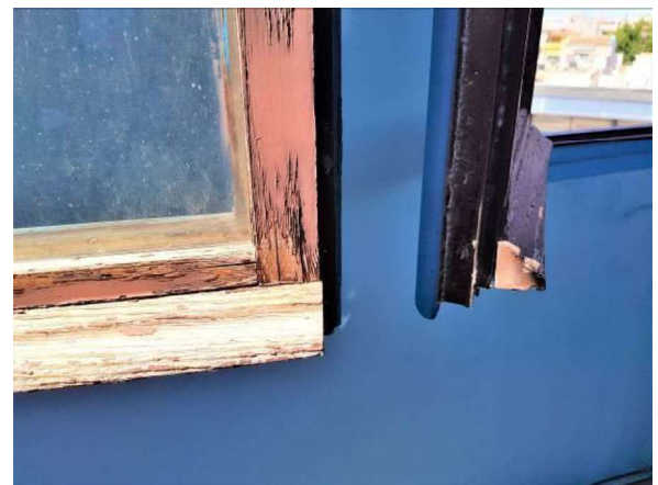
Estat de la fusteria. Finestres i escopidors
