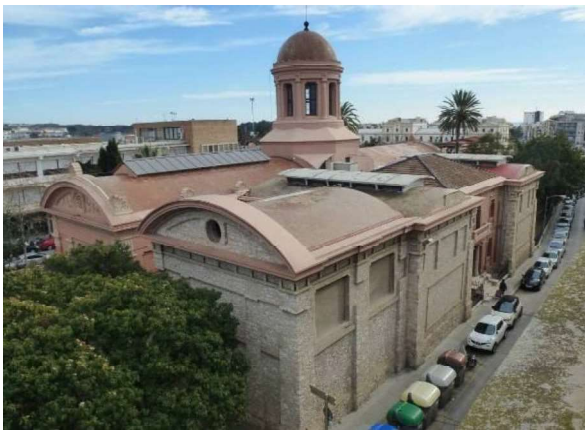
Foto de la façana posterior al carrer Narcís Monturiol, orientada a oest. El cos central és l'original de 1884. Al centre, s'identifica la cúpula al centre de la planta, amb la seva llanterna i el casquet amb acabat enrajolat d'igual manera com estan resoltes la resta de cobertes a excepció de la de l'entrada posterior.
