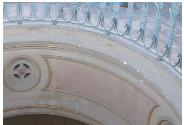
Arestes amb pèrdua de material i degoters
