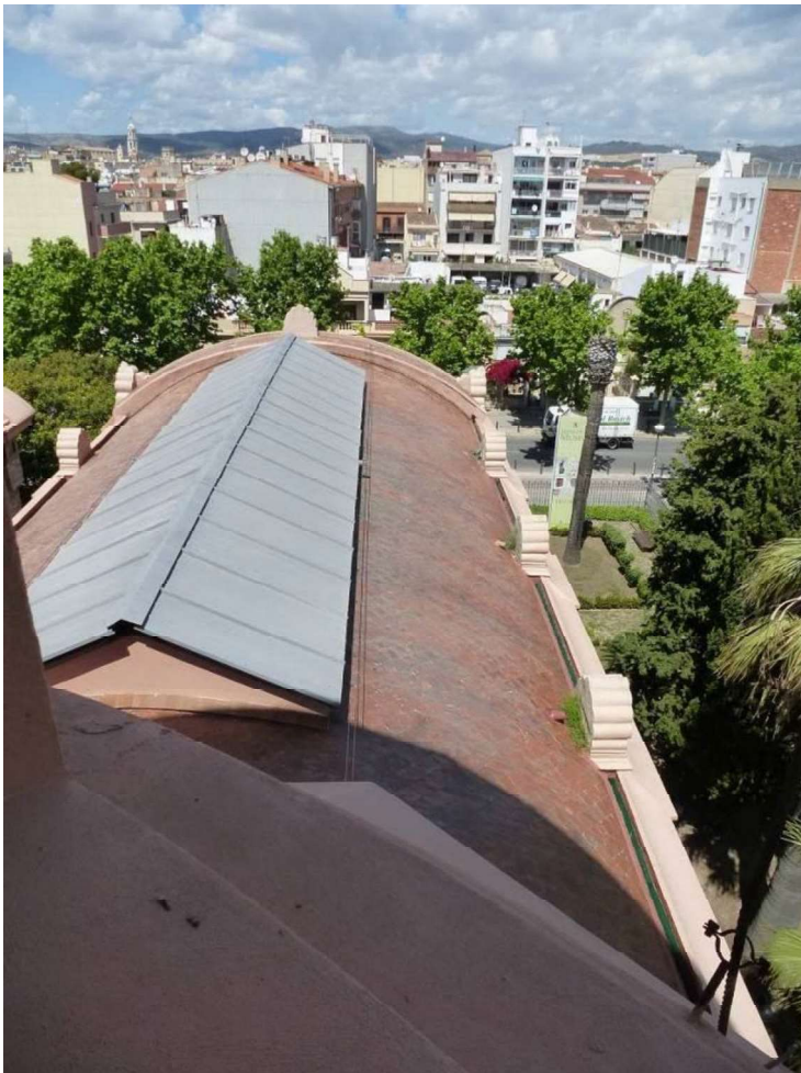
Foto de la coberta sobre la sala Pinacoteca. Vegis també l'acabat enrajolat
