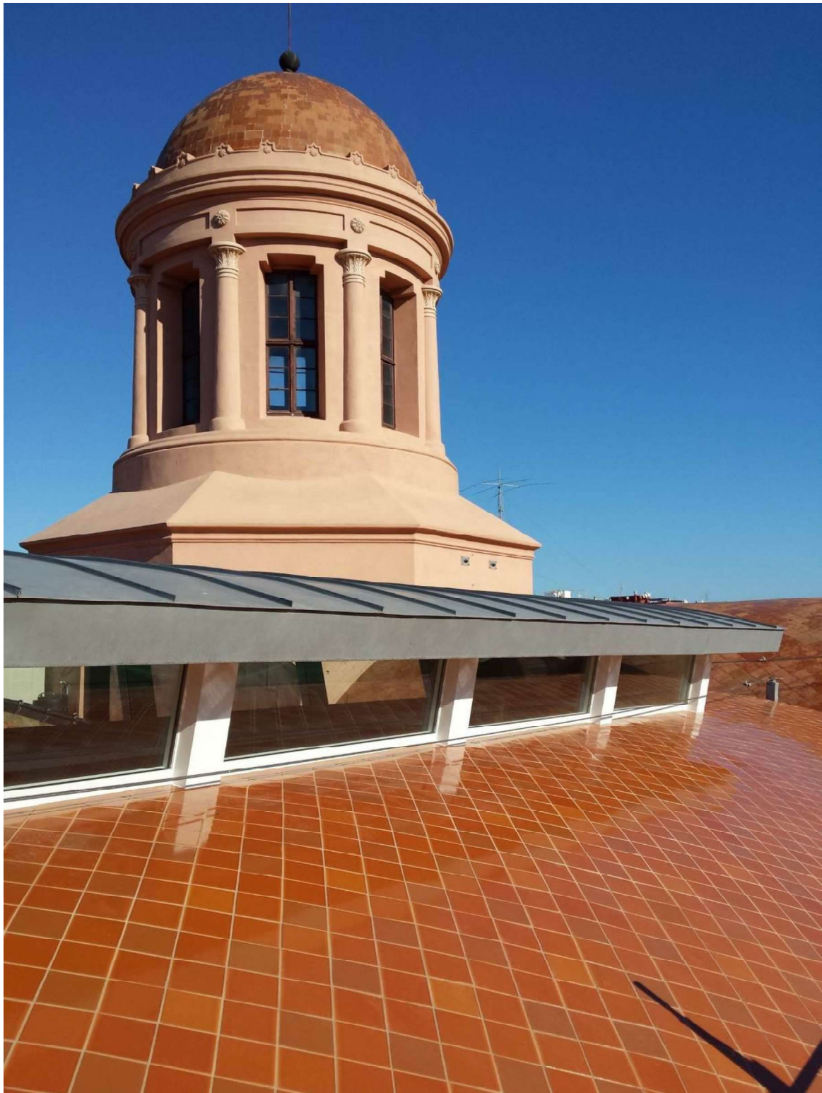
Foto de la coberta sobre la sala Informalistes. Acabat enrajolat segons "Projecte de nous tancaments de la coberta de la sala Informalistes" duta a terme l'any 2017.
