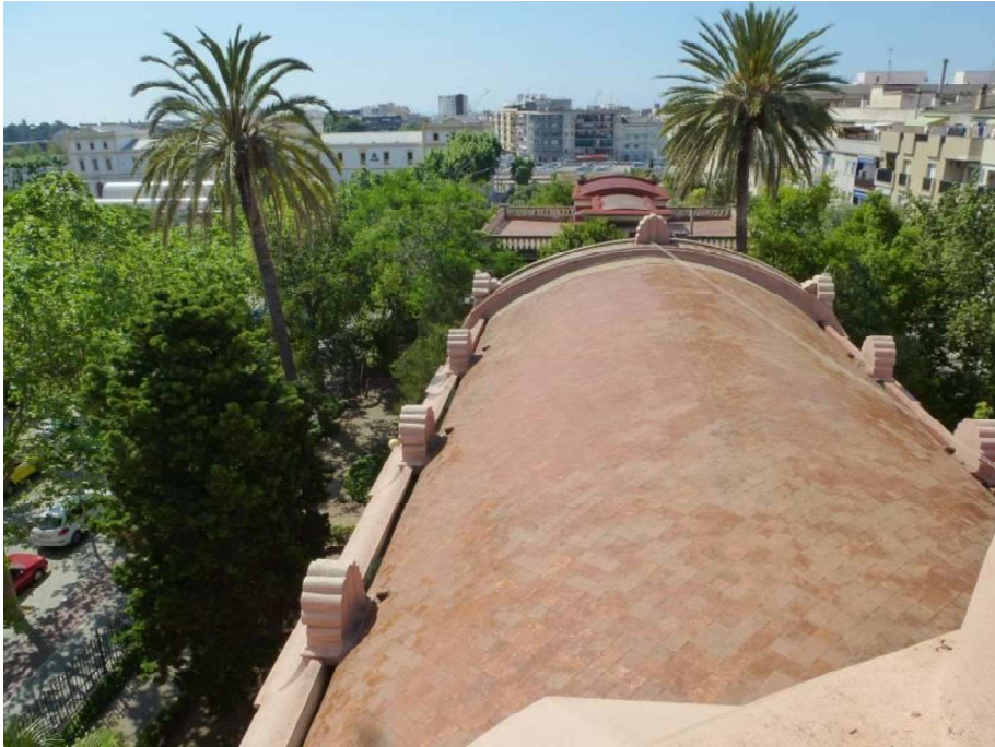
Foto de la coberta sobre la sala Biblioteca. Vegis l'acabat enrajolat
