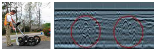
Fig. 4. Detecció de serveis existents amb georàdar.
