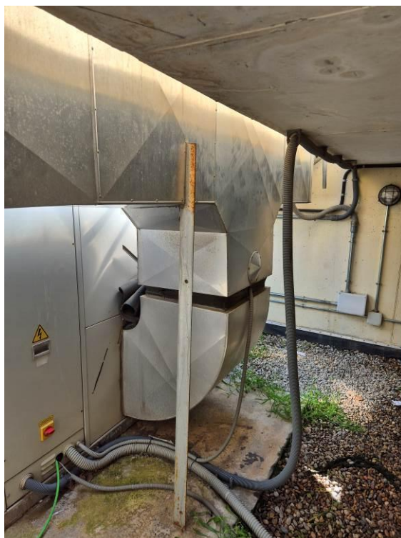
Imatge estat actual maquinària a substituir i conductes
