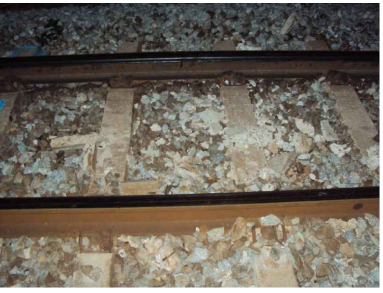
DESPRENIMENT DE MATERIAL A LA VIA
