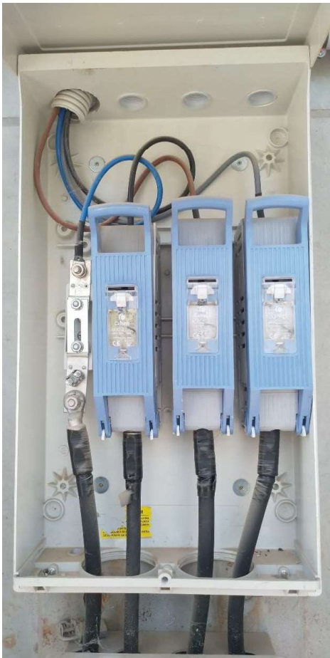
Fig. 24 Vista CGP existent i fusibles
