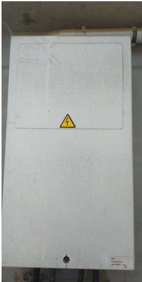
Fig. 24 Vista CGP existent i fusibles
