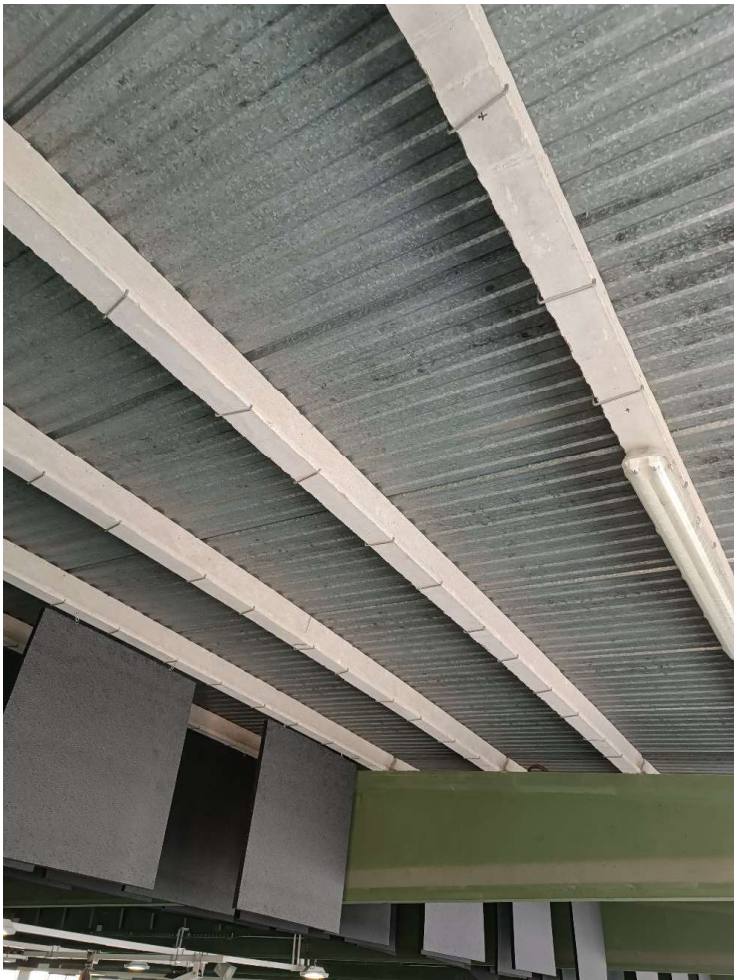
Fig. 19 Vista detall de la composició de l'estructura de la coberta
