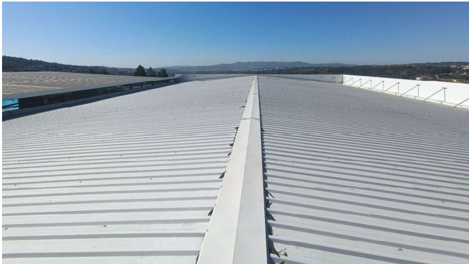
Fig. 18 Vista parcial dues aigües de la coberta
