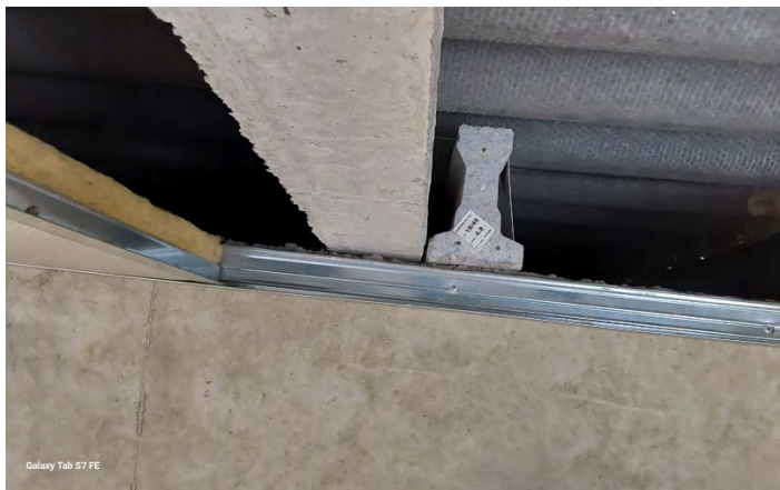
Foto_08: Vista corretges de coberta.
