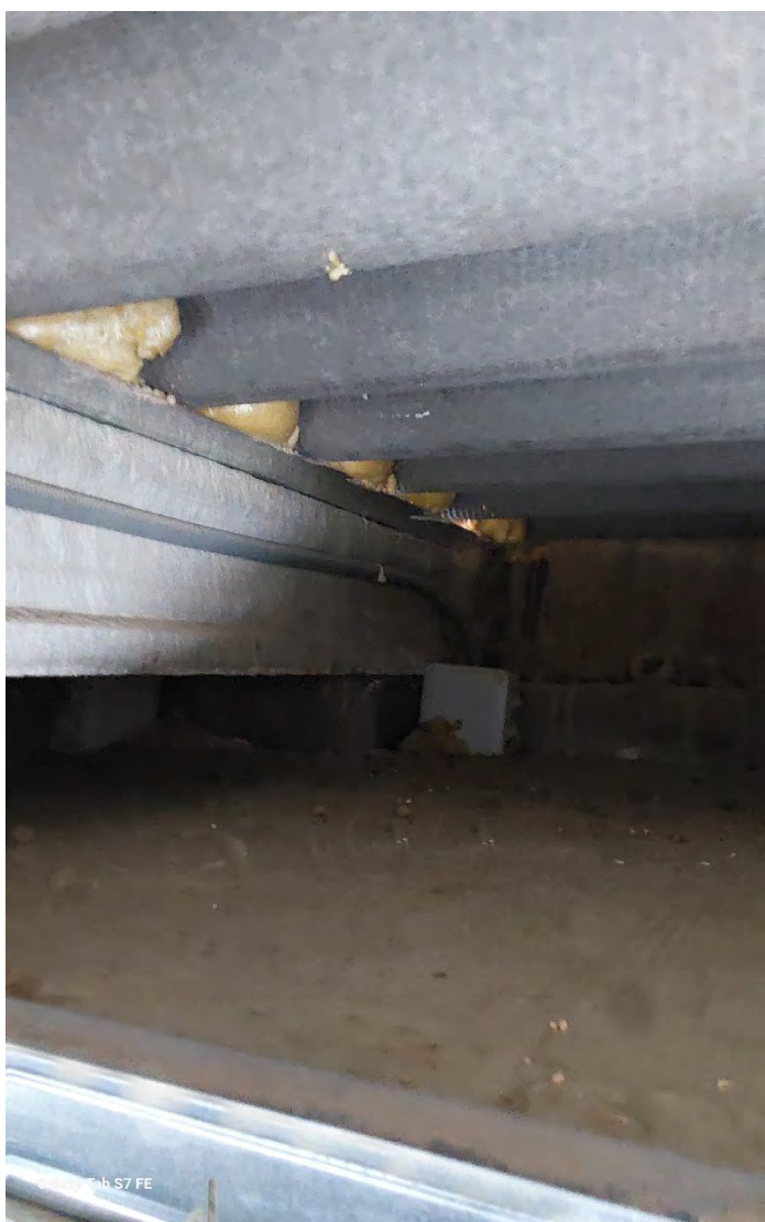
Foto_09: Coberta sobre corretja formigó prefabricat.
