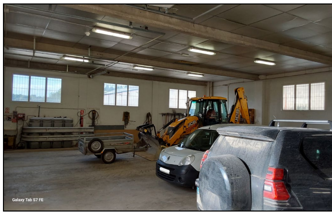
Figura-4. Vista interior del fals sostre de panells llana de roca.
