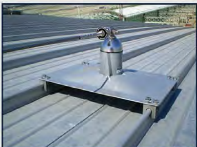
ALUMINIO - JUNTA ENGATILLADA
