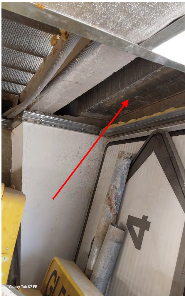
Foto_11: Vista interior canal pluvial de coberta.
