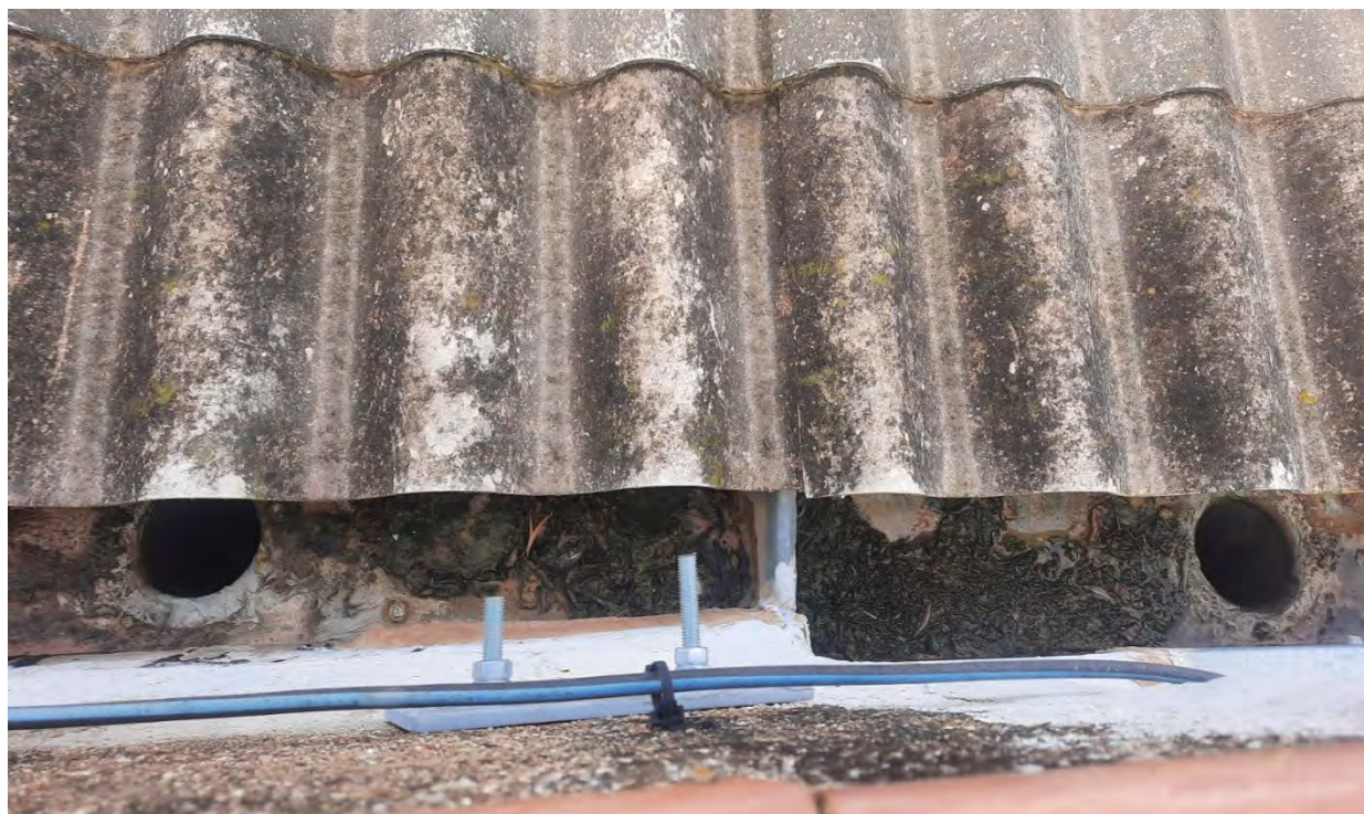
Foto_14: Entrega de baixants pluvials a canal pluvial.
