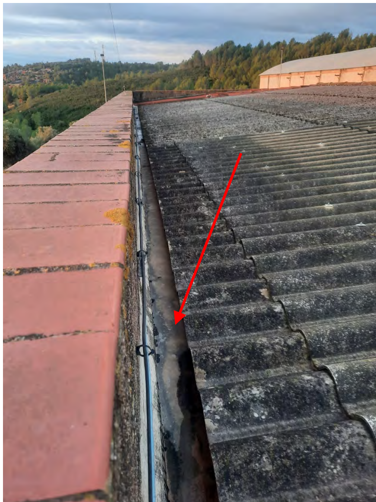
Foto_12: Vista exterior Canal pluvial de coberta.
