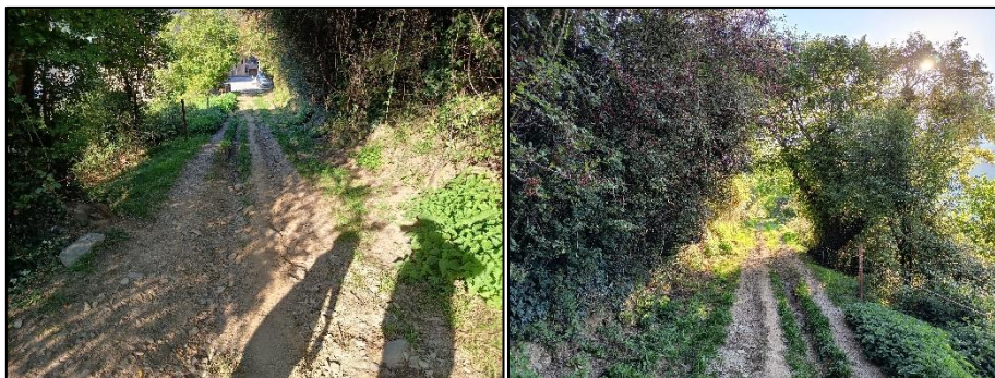
Paviment a millorar amb Tot-u
