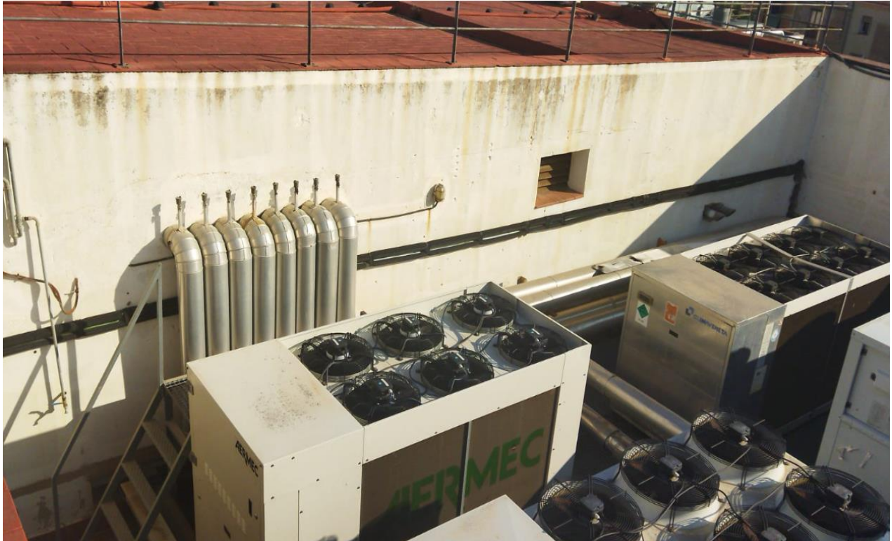
Col·lector existent. Paret a on es col·locaran les noves canonades
